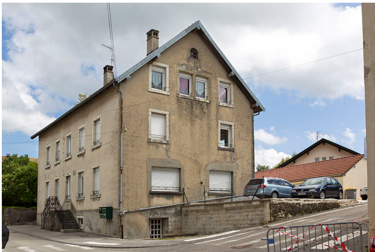
Façades antérieure et latérale droite.
