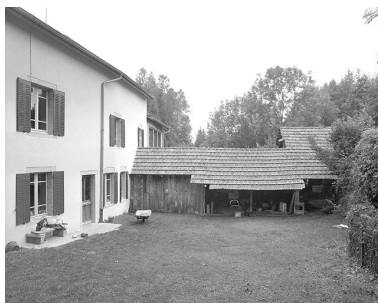
ferme, moulin à farine, scierie, atelier de tournerie dit moulin de la Rochette ou moulin d'Aval, actuellement maison, atelier de poterie Phot. Jérôme Mongreville IVR43_19963901420X
