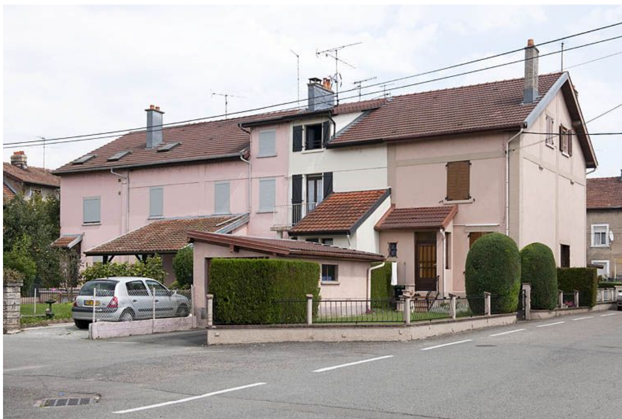
Habitation à 8 logements. Façade ouest.
