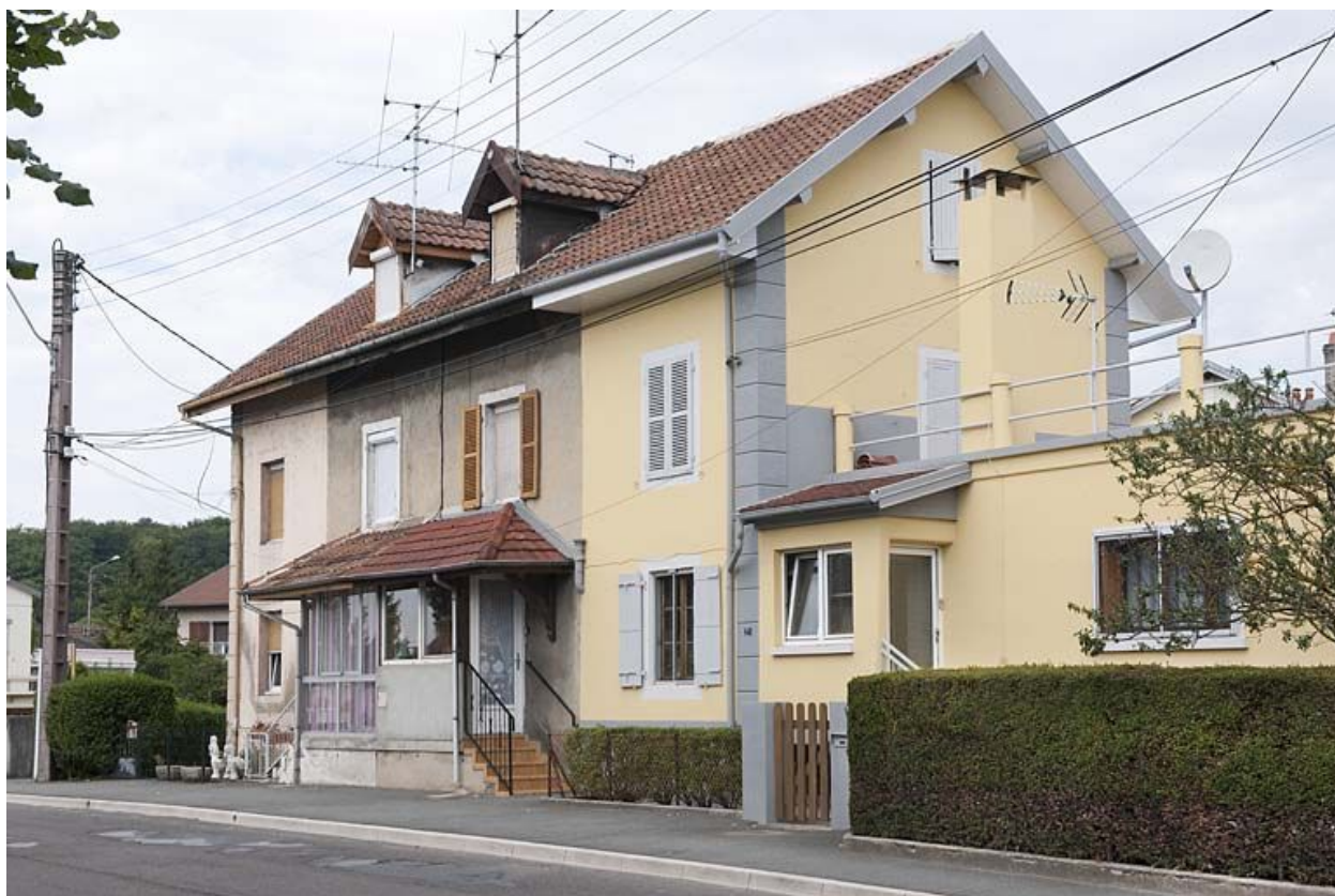
Habitation à 4 logements depuis l'avenue Jean Jaurès.
