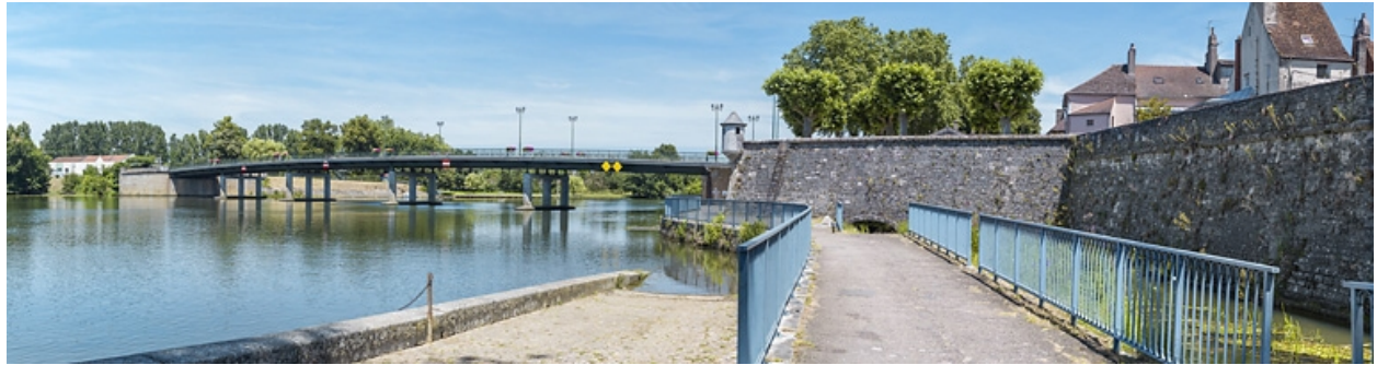
Vue du bastion en aval du pont.
