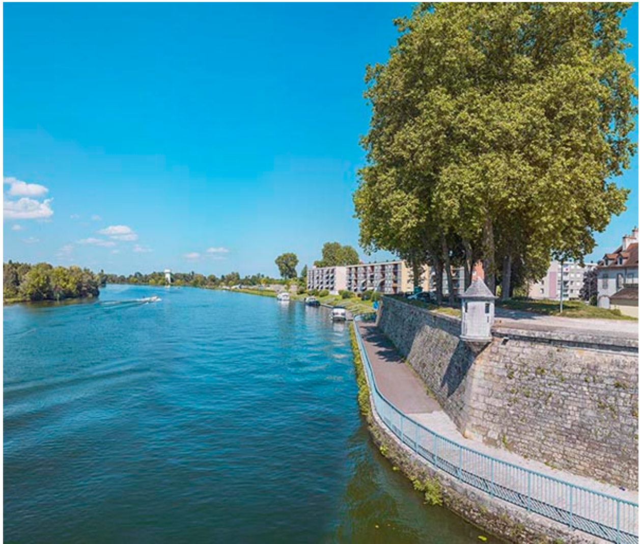
Vue du bastion en amont du pont.
