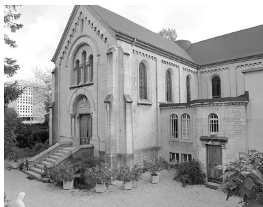
Eglise : vue générale. Phot. Yves Sancey IVR43_19833900551X
