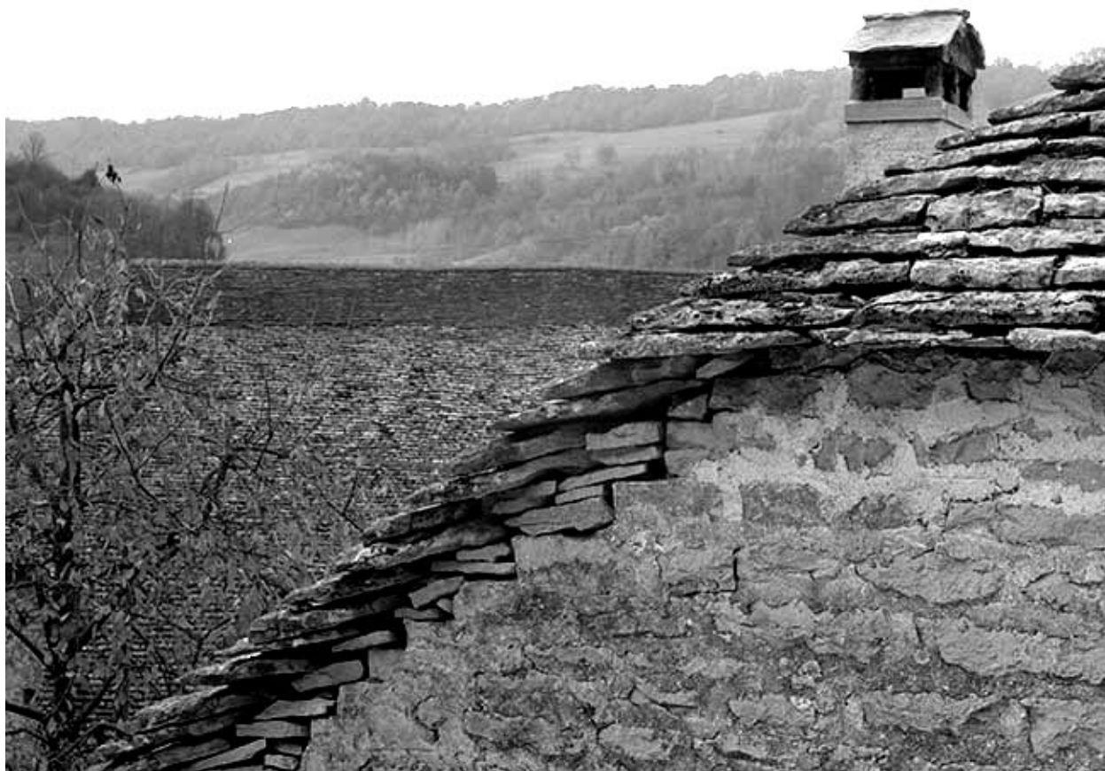
Détail d'une bordure de toit en laves.
