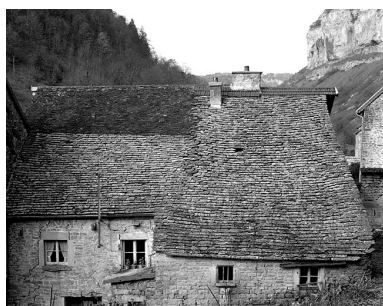
Détail d'une toiture en laves.
