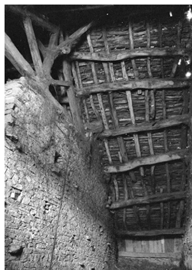
Ferme cadastrée 1960 B 109, située au lieudit La Peyrouse : charpente de toit de laves. Phot. F. Pernin IVR43_19743900259Z
