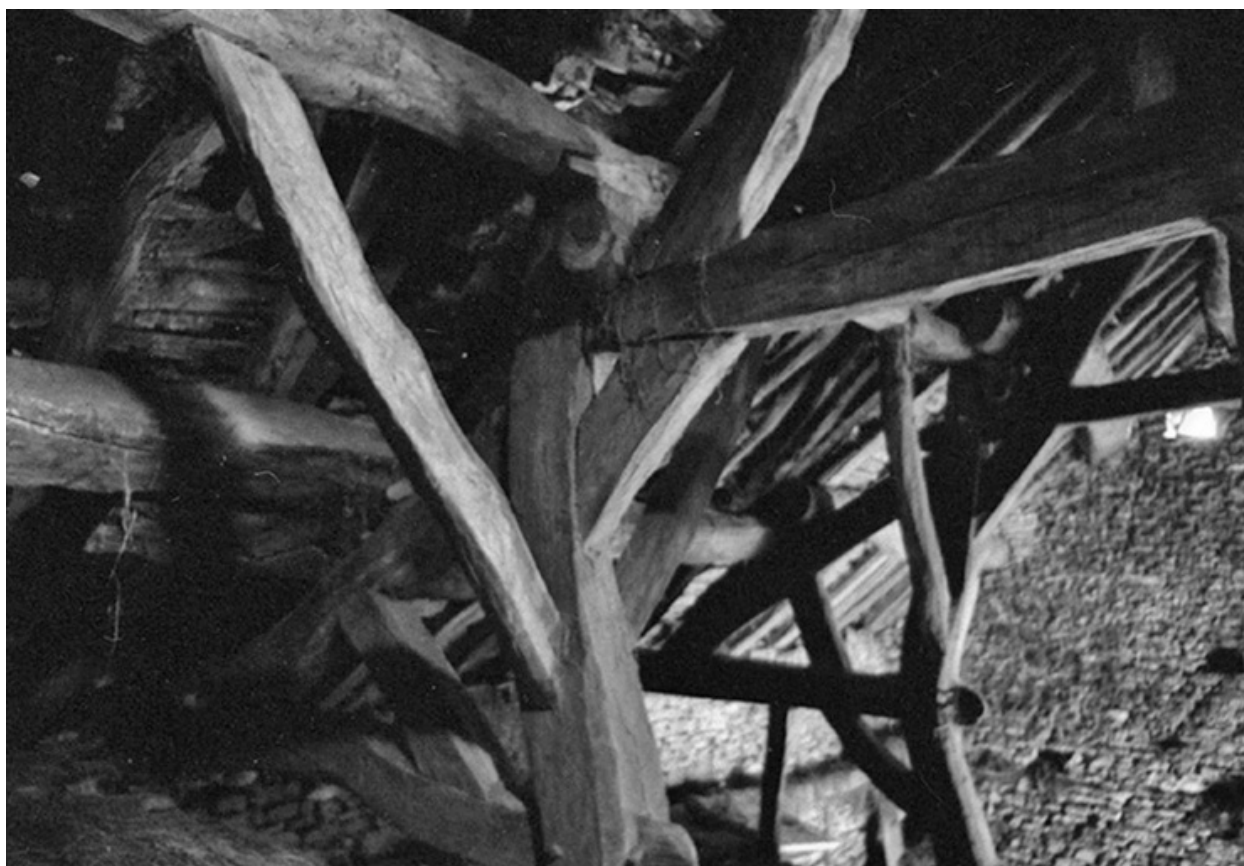
Ferme cadastrée 1960 B 107, située au lieudit La Peyrouse : détail de la charpente d'un toit en laves.
