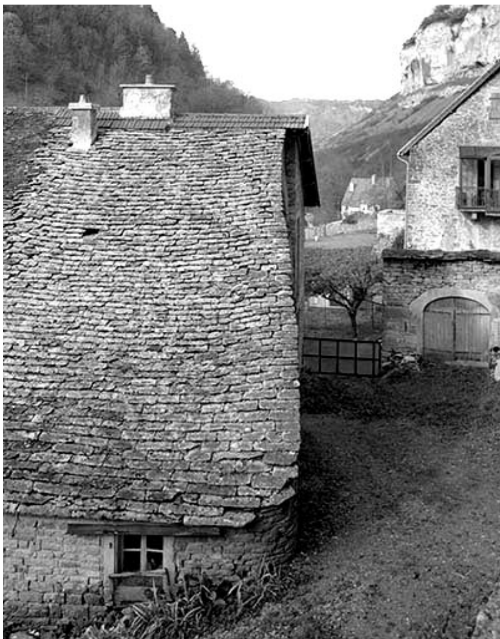
Détail d'une toiture en laves.
