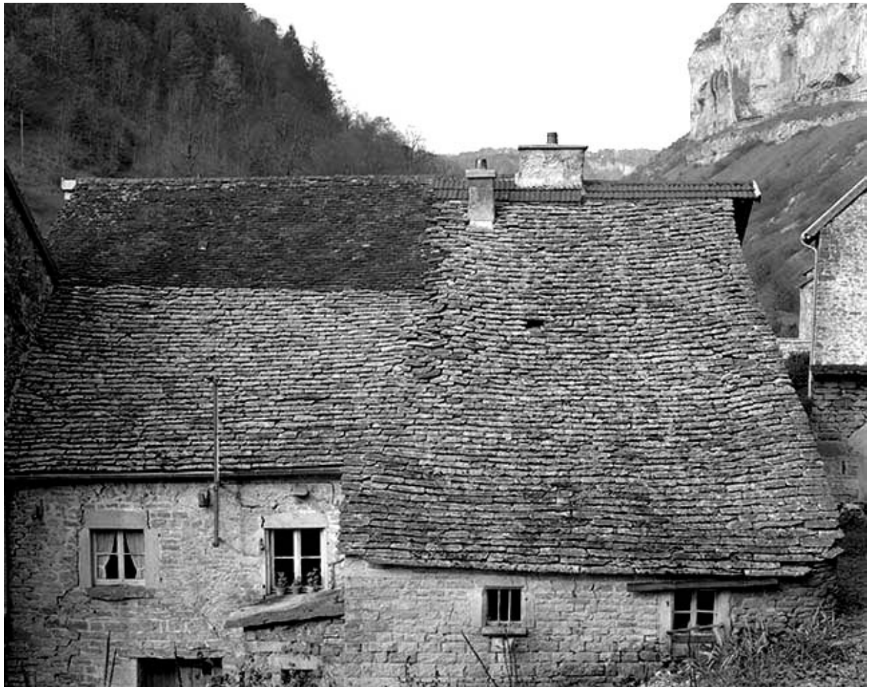
Détail d'une toiture en laves.
