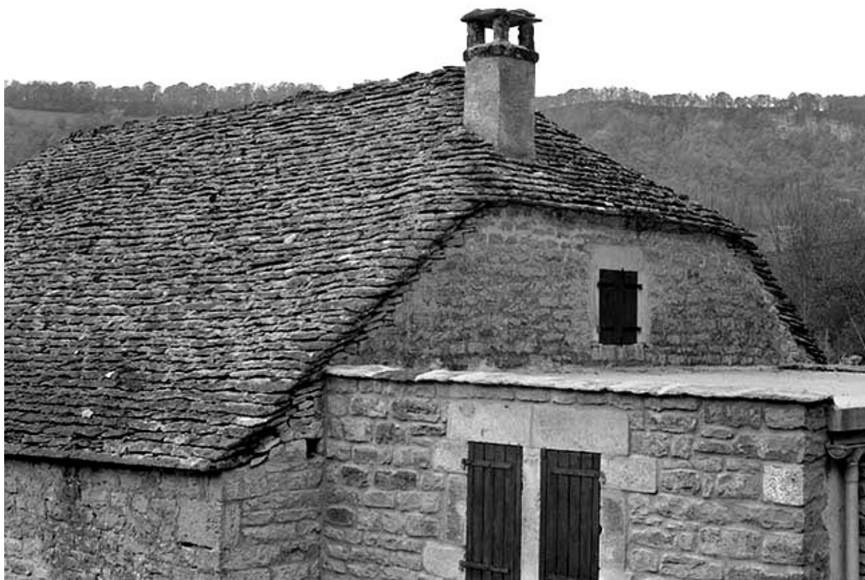
Détail d'une toiture en laves.
