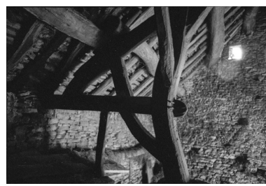
Ferme cadastrée 1960 B 107, située au lieudit La Peyrouse : détail de la charpente d'un toit en laves. Phot. F. Pernin IVR43_19743900253Z
