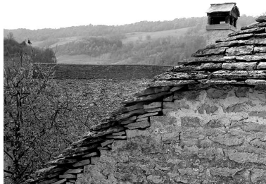
Détail d'une bordure de toit en laves.
