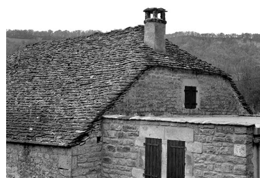
Détail d'une toiture en laves.
