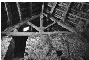
Ferme cadastrée 1960 B 109, située au lieudit La Peyrouse : charpente de toit de laves. Phot. F. Pernin IVR43_19743900260Z
