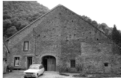
Ferme cadastrée 1960 C 562, située au lieudit La Peyrouse : façade antérieure. Phot. F. Pernin IVR43_19743900174Z
