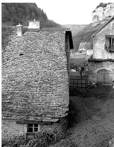
Détail d'une toiture en laves.
