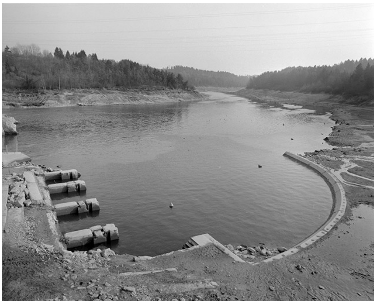
Fondations et bassin d'amortissement.
