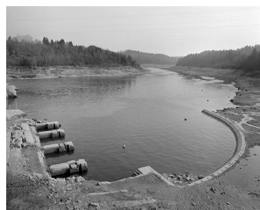
Fondations et bassin d'amortissement. Phot. Jérôme Mongreville IVR43_19963900111X
