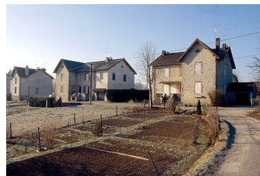
Vue de la cité ouvrière depuis le nord. Phot. Jérôme Mongreville IVR43_19963900153ZA
