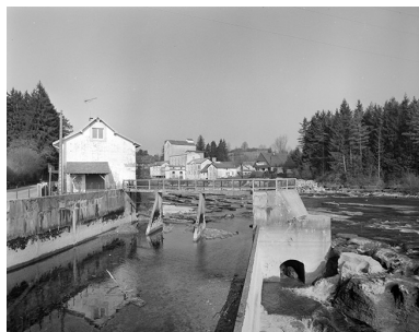
Logement et canal d'amenée. Phot. Jérôme Mongreville IVR43_19963900050X
