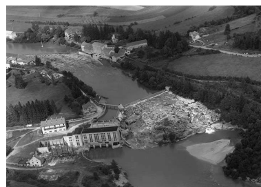
Vue aérienne en 1956 Phot. Roger Henrard IVR43_19563900085N
