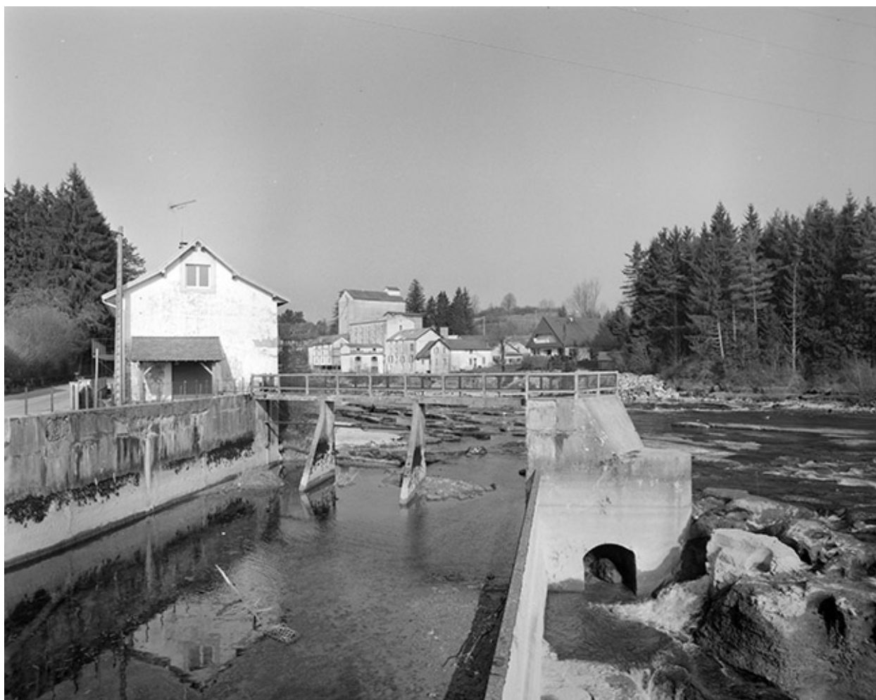
Logement et canal d'amenée.
