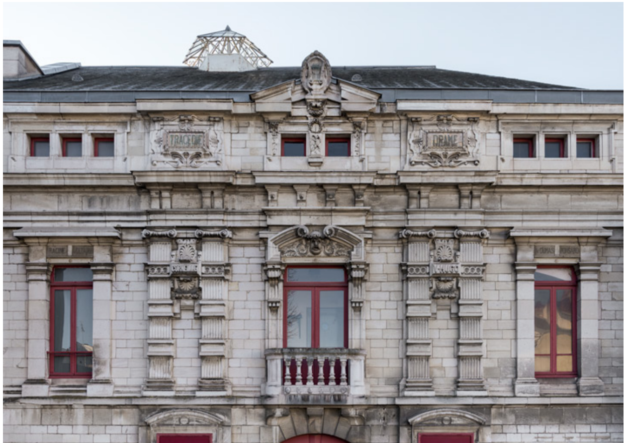
Façade latérale gauche : étage carré et attique.
