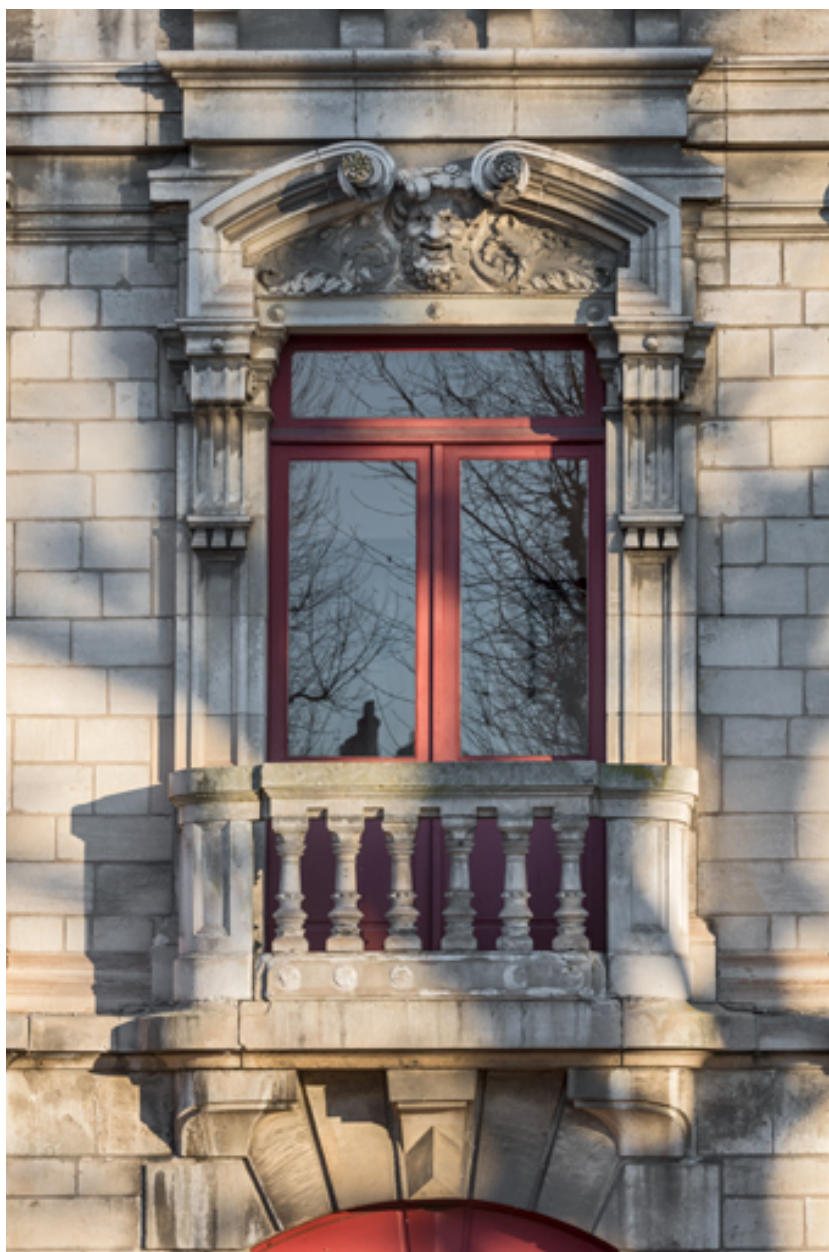
Façade latérale droite, étage carré : baie centrale.
