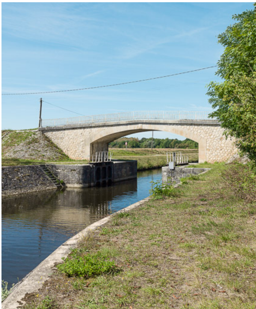
Vue d'ensemble du pont.
