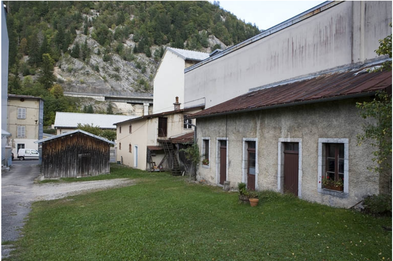
Buanderie, entrepôt et garage.
