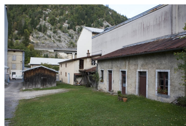
Buanderie, entrepôt et garage. Phot. Yves Sancey IVR43_20093900127NUC2A
