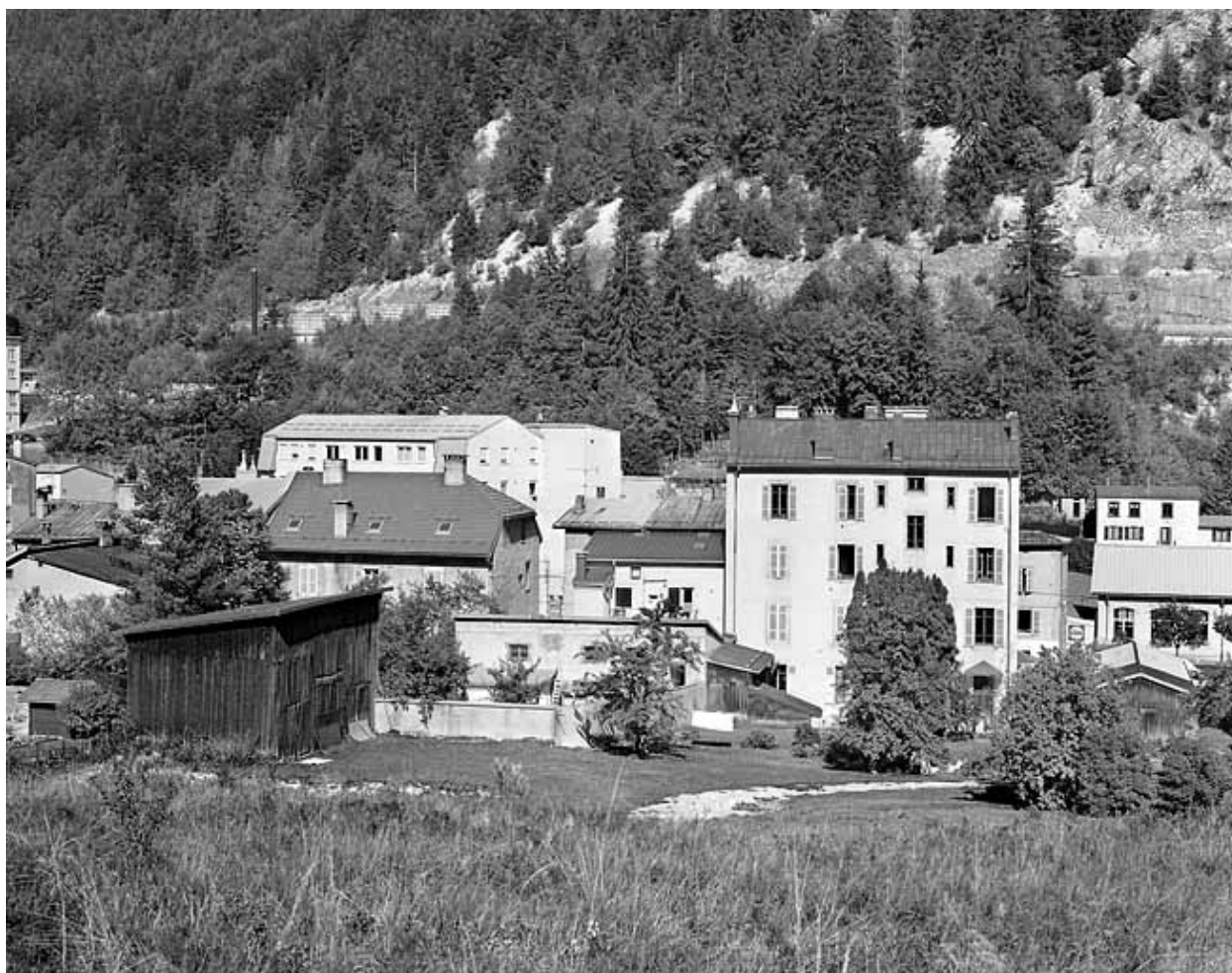
Vue d'ensemble depuis l'ouest : élévation postérieure.
