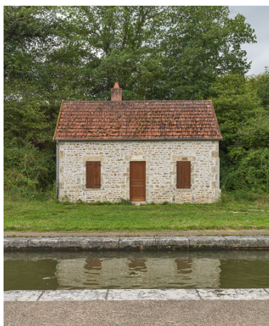
VUE de la maison éclusière. Phot. Pierre-Marie Barbe-Richaud IVR26_20175800318NUC2A
