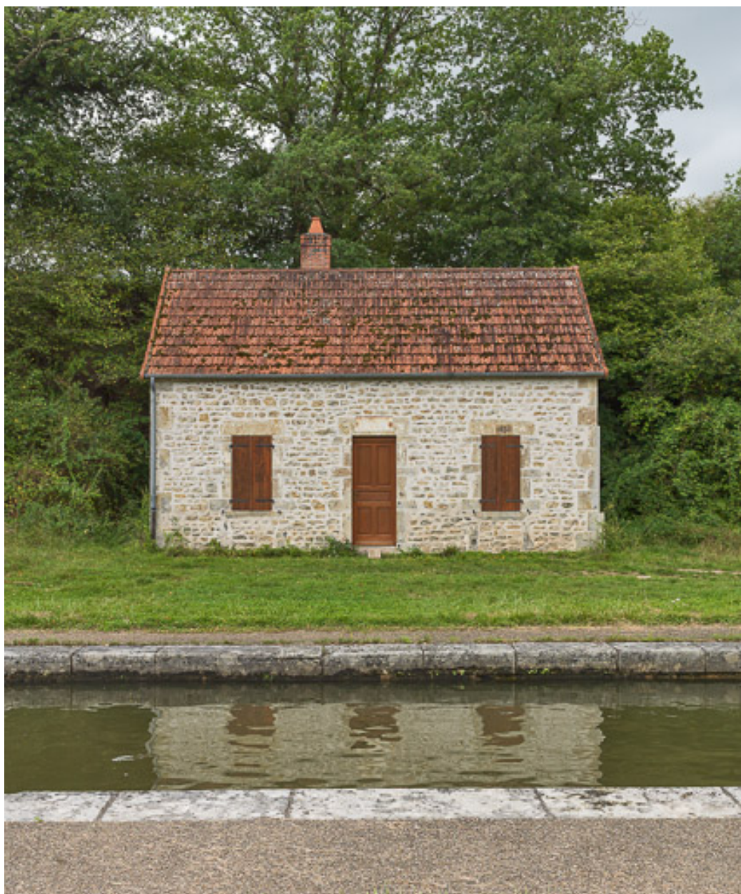
VUe de la maison éclusière.
