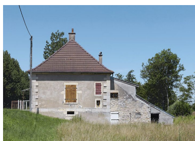
Maison éclusière vue de côté. Phot. Thierry Kuntz IVR26_20112103250NUC2A
