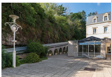
Aqueduc, vue depuis la cour de l'établissement thermal. Phot. Pierre-Marie Barbe-Richaud IVR26_20217100185NUC4A
