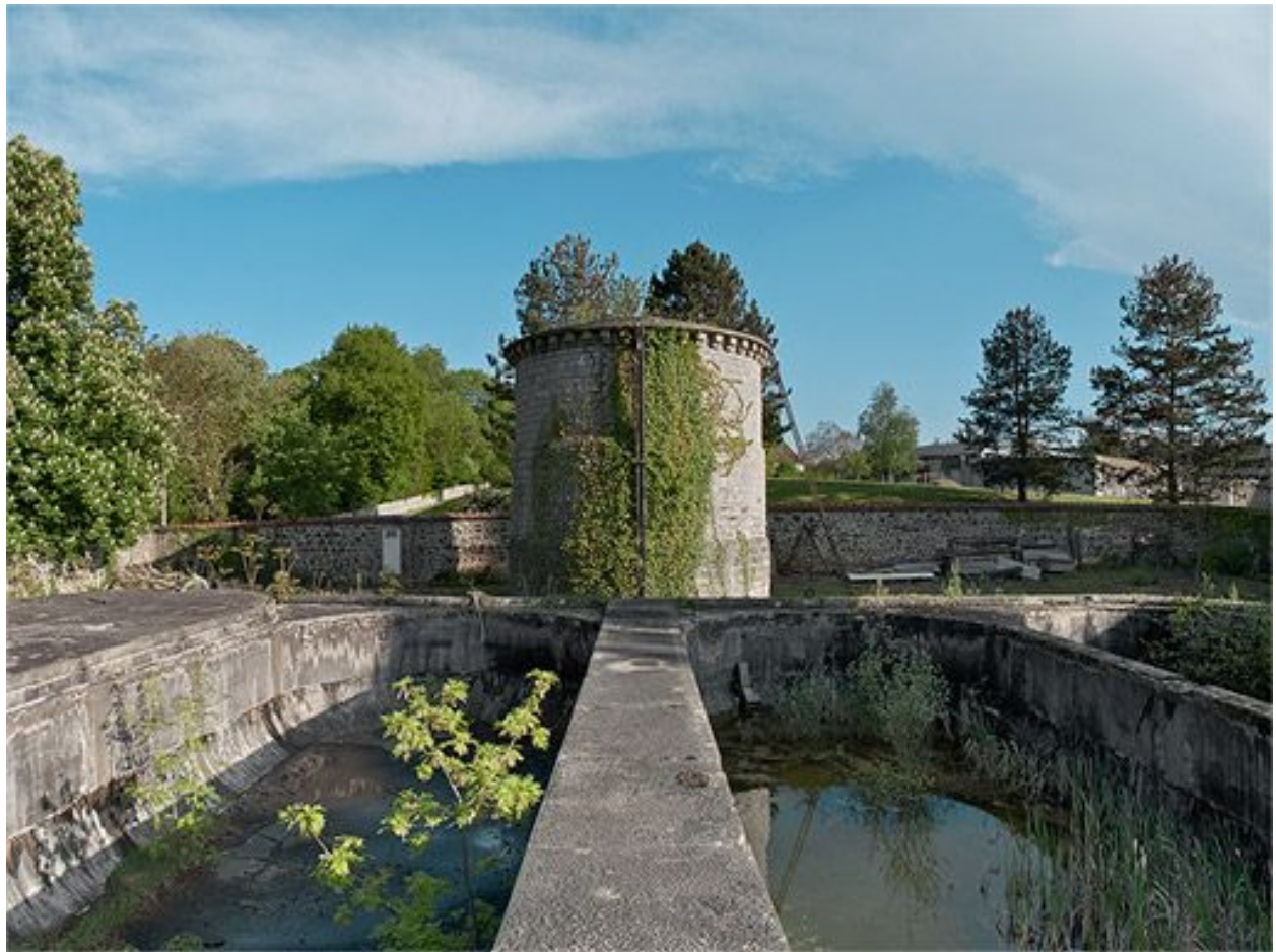
Vue depuis le réservoir, en direction du château d'eau.
