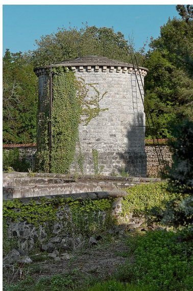
Château d'eau. Phot. Pierre-Marie Barbe-Richaud IVR26_20107100988NUC2A
