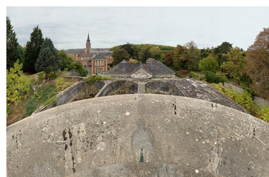
Vue depuis le château d'eau, en direction du réservoir et des bains d'Aligre. Phot. Pierre-Marie Barbe-Richaud IVR26_20107100991NUC4AQ
