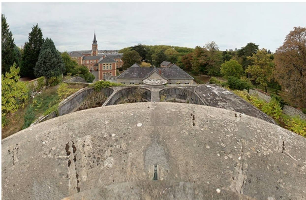
Vue depuis le château d'eau, en direction du réservoir et des bains d'Aligre.
