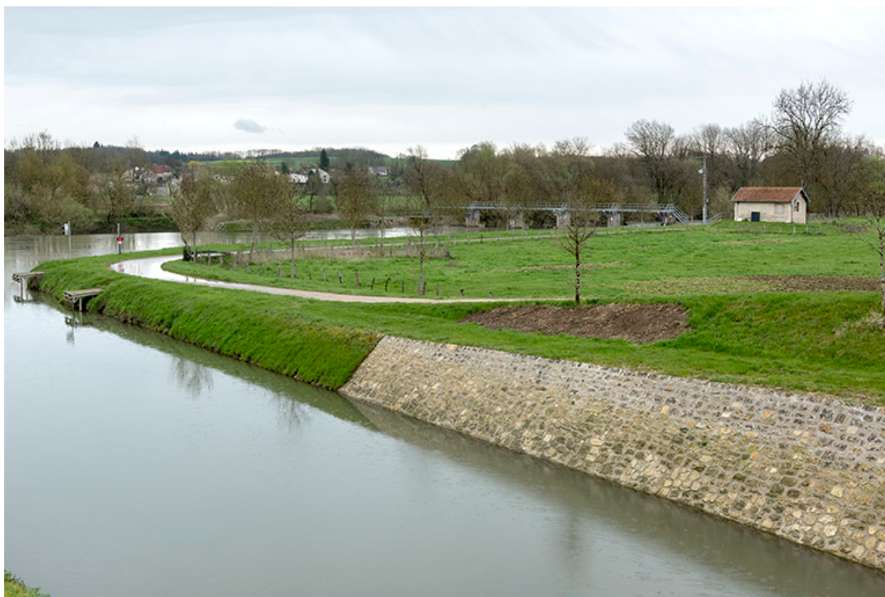
Vue depuis l'entrée amont du canal.
