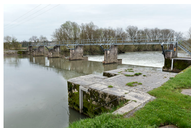
Vue générale du barrage. Phot. Sonia Dourlot IVR43_20167000281NUC4A
