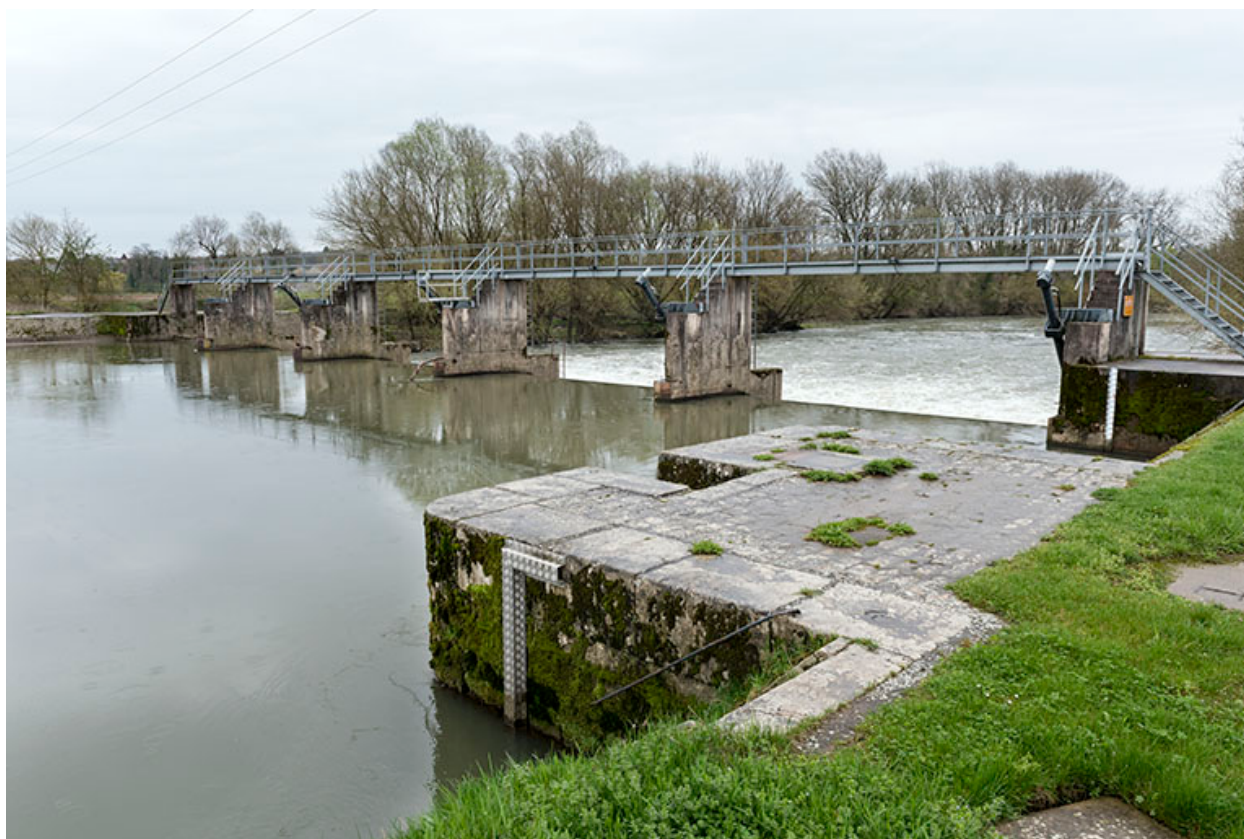
Vue générale du barrage.
