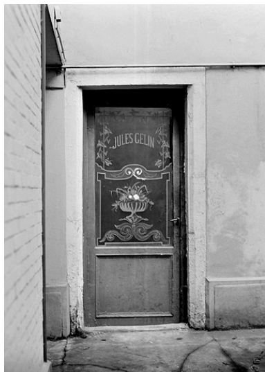
Porte du corps de bâtiment en fond de cour. Sur la vitre figure le nom de Julin Gelin qui tenait un café-concert dans cette demeure à la fin du siècle dernier. Phot. Jérôme Mongreville IVR43_19872500811X
