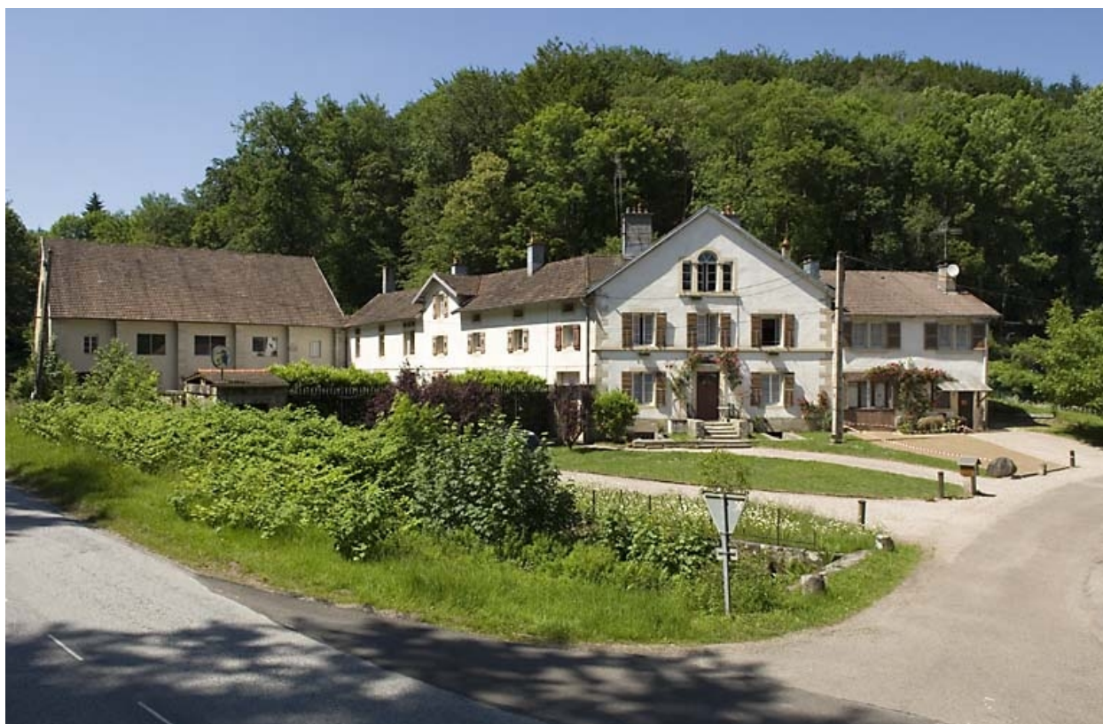
Ecole et logement (commune du Clerjus, 88).
