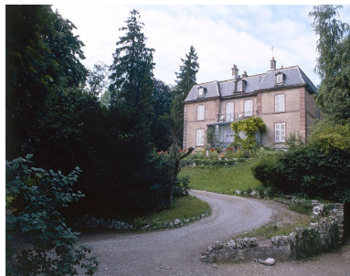
Vue d'ensemble du corps de bâtiment principal. Phot. Jérôme Mongreville IVR43_19872500523XA
