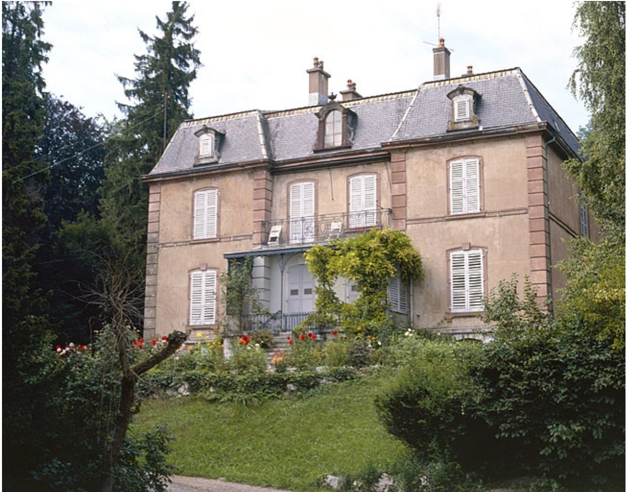
Façade sud du corps de bâtiment principal.
