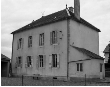
Elévation postérieure. Phot. Michel Rosso IVR26_19862100146X
