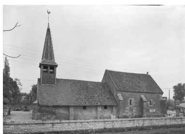
Elévation droite Phot. Michel Thierry IVR26_19862101139V
