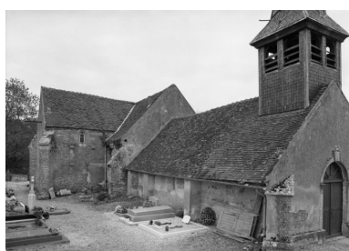
Elévation gauche Phot. Michel Thierry IVR26_19862101143V
