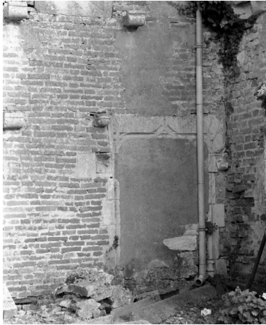
Chapelle seigneuriale, porte du mur antérieur Phot. Jean-Luc Duthu IVR26_19862101145X
