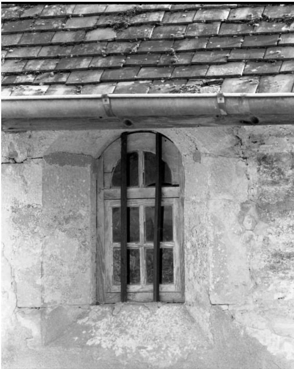
Elévation gauche, 1ère fenêtre de la nef
