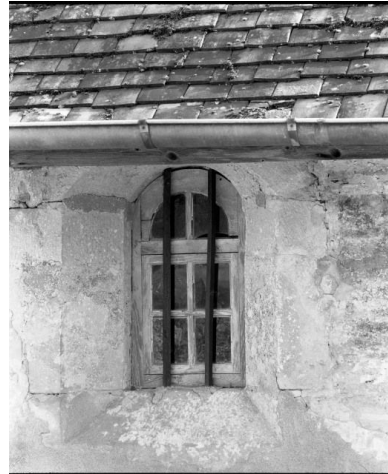
Elévation gauche, 1ère fenêtre de la nef Phot. Jean-Luc Duthu IVR26_19862101147X
