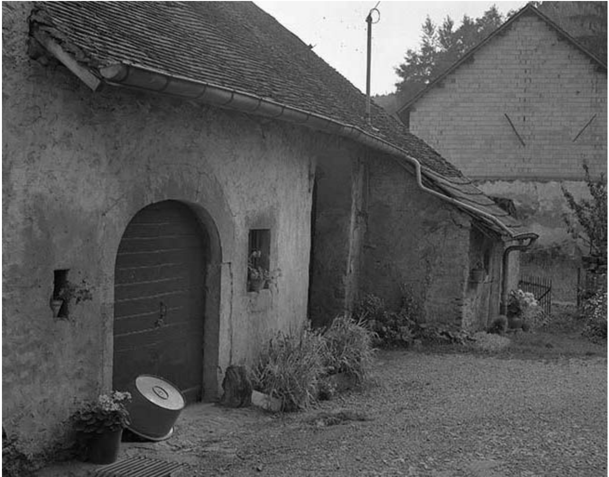
Façade antérieure vue de trois quarts gauche.
