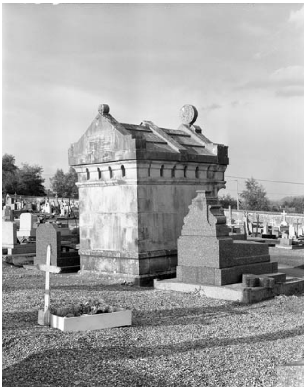
Façades postérieure et latérale gauche.
