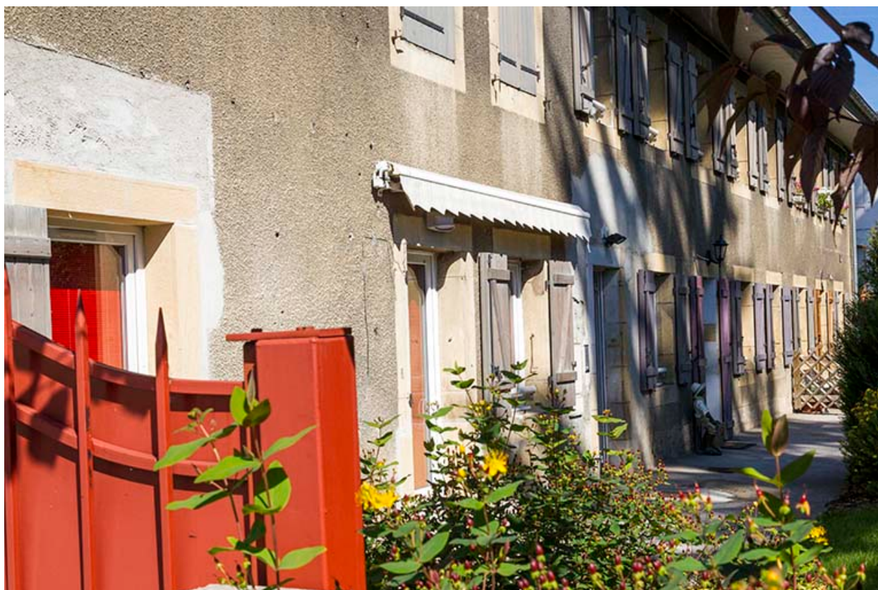
Façade latérale droite.
