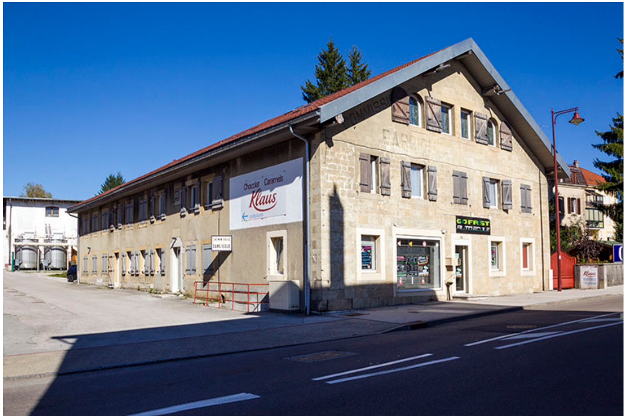
Façades antérieure et latérale gauche.
