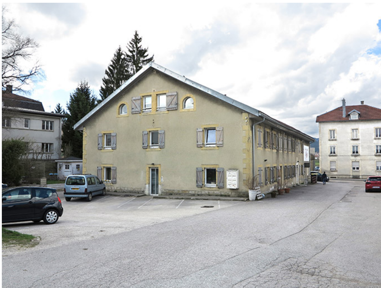
Façades postérieure et latérale gauche.
