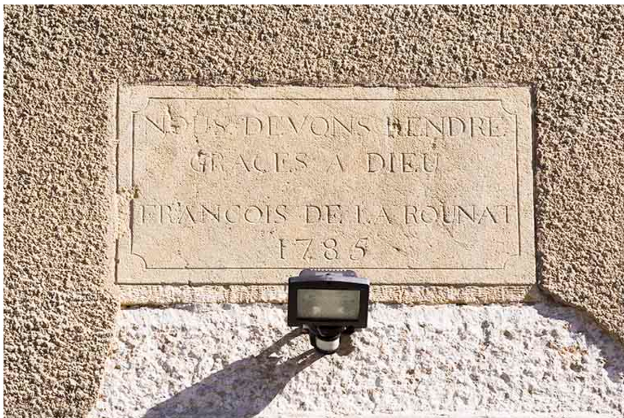
Façade latérale gauche : inscription et date 1785.
