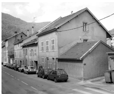
Façades sur la rue du Faubourg Marcel. Phot. Jérôme Mongreville IVR43_19923900515X
