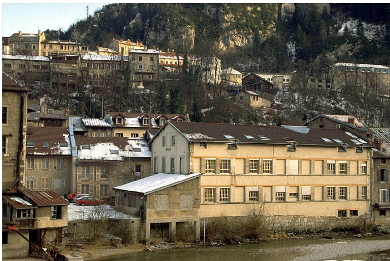
Façade postérieure de l'usine.
