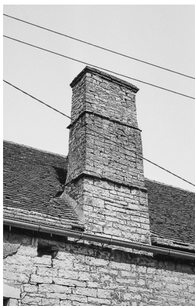
Détail : cheminée. Phot. Bernard Lardière IVR43_19817000317Z
