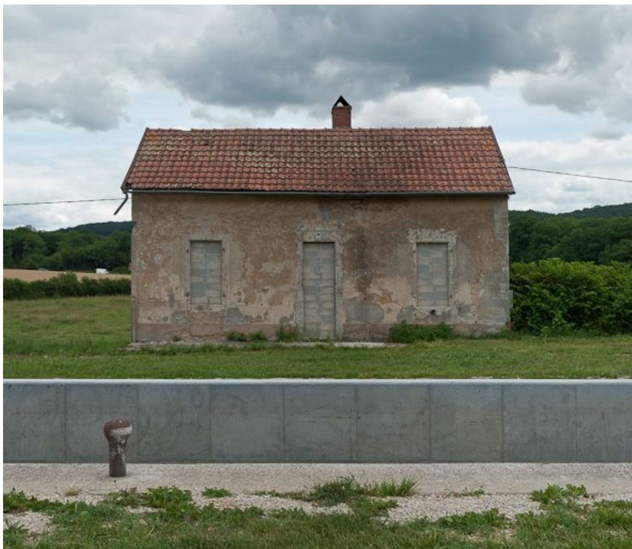
Vue de face de la maison éclusière.
