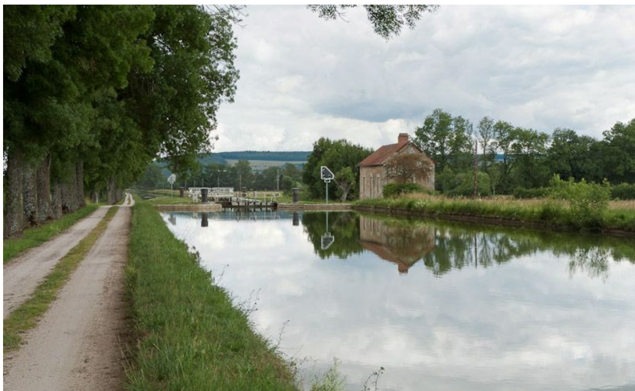
Vue d'ensemble du site d'écluse.
