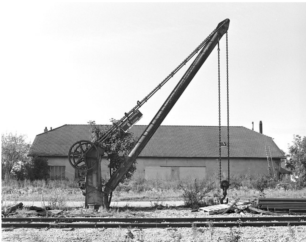
Vue d'ensemble de profil, depuis le nord-est.
