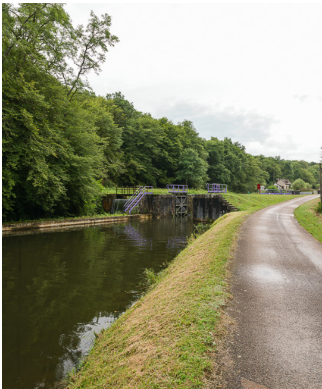
Vue du déversoir de superficie.
