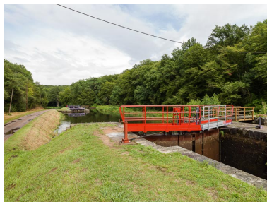
Vue du sas. Phot. Pierre-Marie Barbe-Richaud IVR26_20175800255NUC2A
