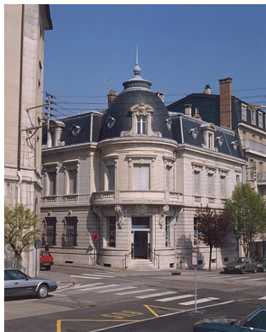
Façade antérieure. Phot. Yves Sancey IVR43_19883900095XA
