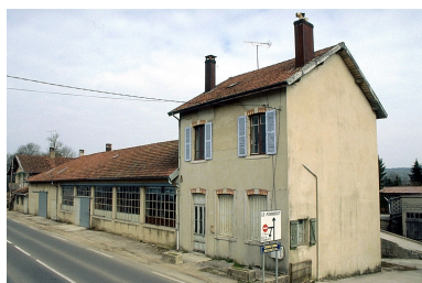
Atelier de fabrication (tableterie) et logement. Phot. Jérôme Mongreville IVR43_19963900150ZA
