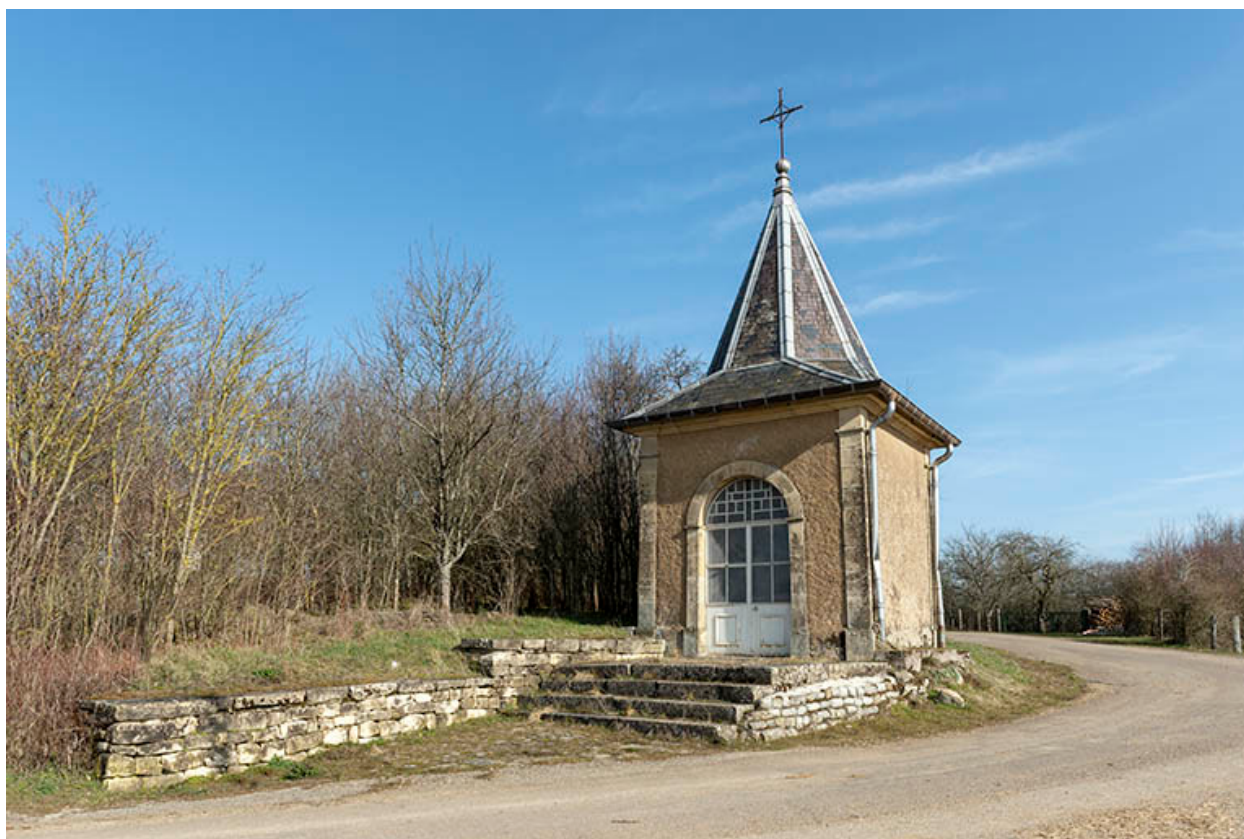
Vue de trois quart depuis l'ouest.
