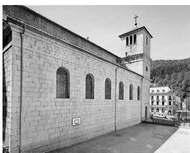
Façade latérale gauche. Phot. Jérôme Mongreville IVR43_20003900694V
