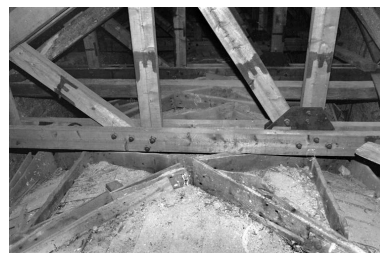
Extrados de la fausse voûte d'arêtes de l'un des bas-côtés. Phot. Jérôme Mongreville IVR43_20003900733Z
