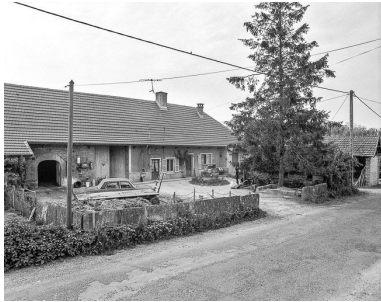
Ferme située rue du Centre.
