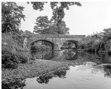
Pont sur la Vallière. Phot. Yves Sancey IVR43_19843900021X
