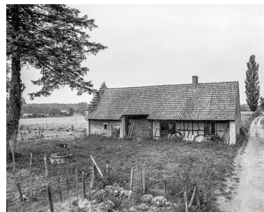
Ferme située au lieudit Les Prés. Phot. Yves Sancey IVR43_19843900033X
