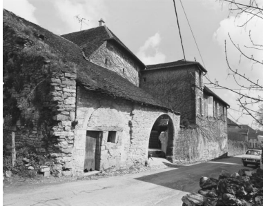
Vue générale depuis la rue. Phot. Dominique Dominguez IVR43_19783900143X
