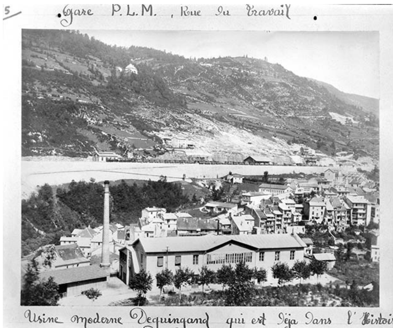
Doc. 01. Vue d'ensemble depuis le sud.
