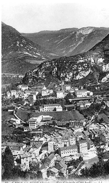
Saint-Claude (Jura).- Vue Générale (côté sud). Phot. Jérôme Mongreville IVR43_19923900171X
