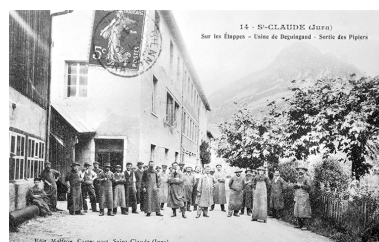
St-Claude (Jura). Sur les Etapes - Usine de Deguingand - Sortie des Pipiers. Phot. Jérôme Mongreville IVR43_19923900086X
