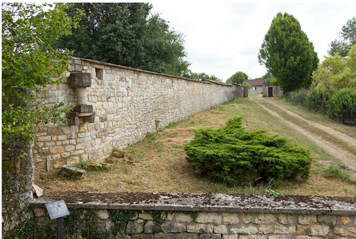
Le mur d'enclos du couvent.
