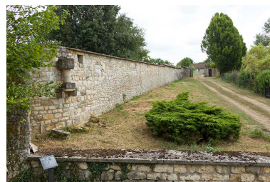
Le mur d'enclos du couvent.
