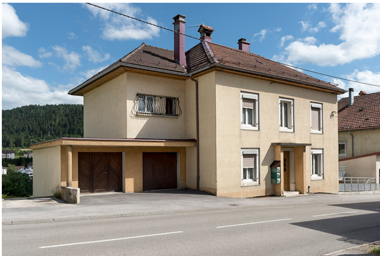
Façades antérieure et latérale gauche.
