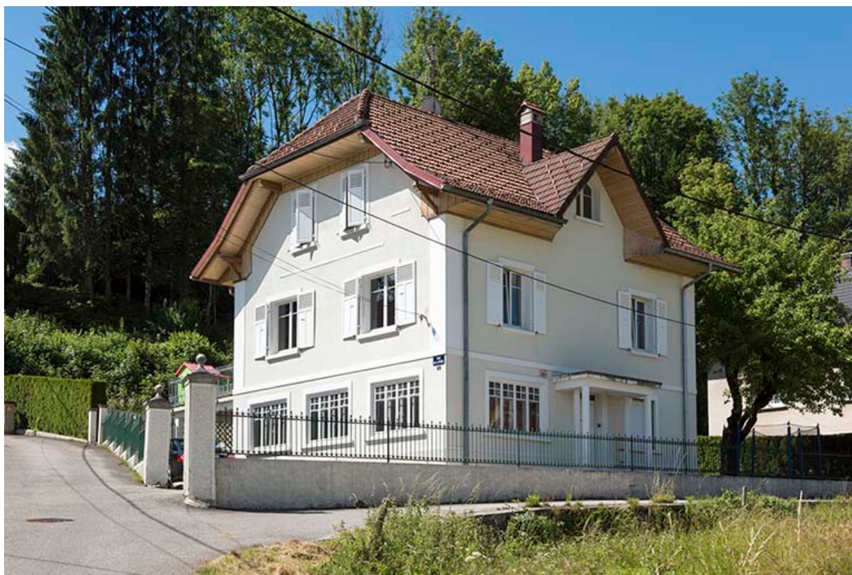
Façades antérieure et latérale gauche.
