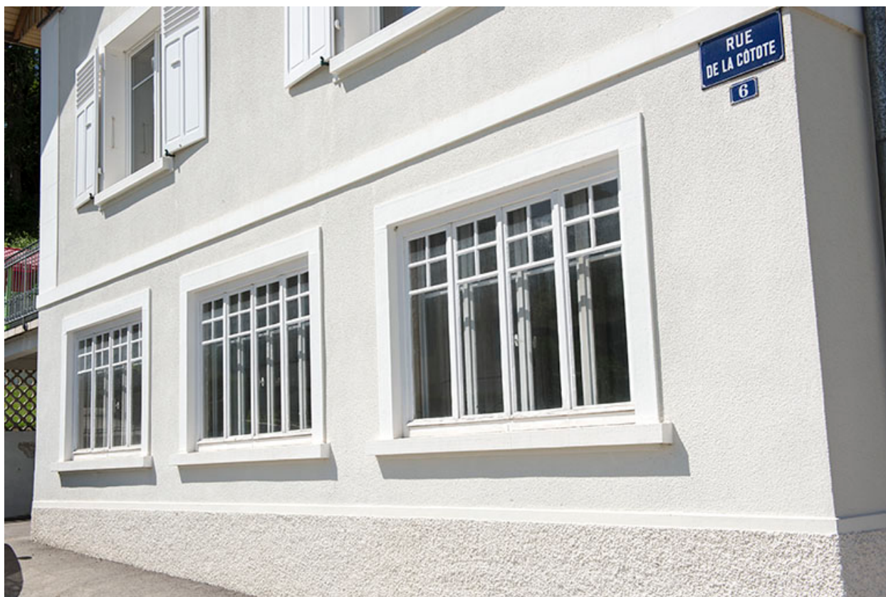
Façade latérale gauche : baies d'atelier.
