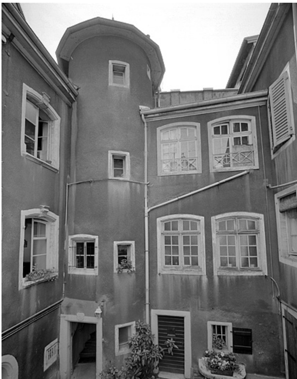
Galleries de liaison et tour d'escalier.
