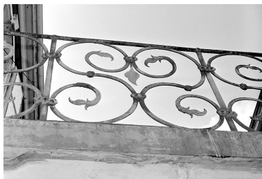
Détail du garde-corps de l'ancienne galerie en terrasse. Phot. Jérôme Mongreville IVR43_19872500888X
