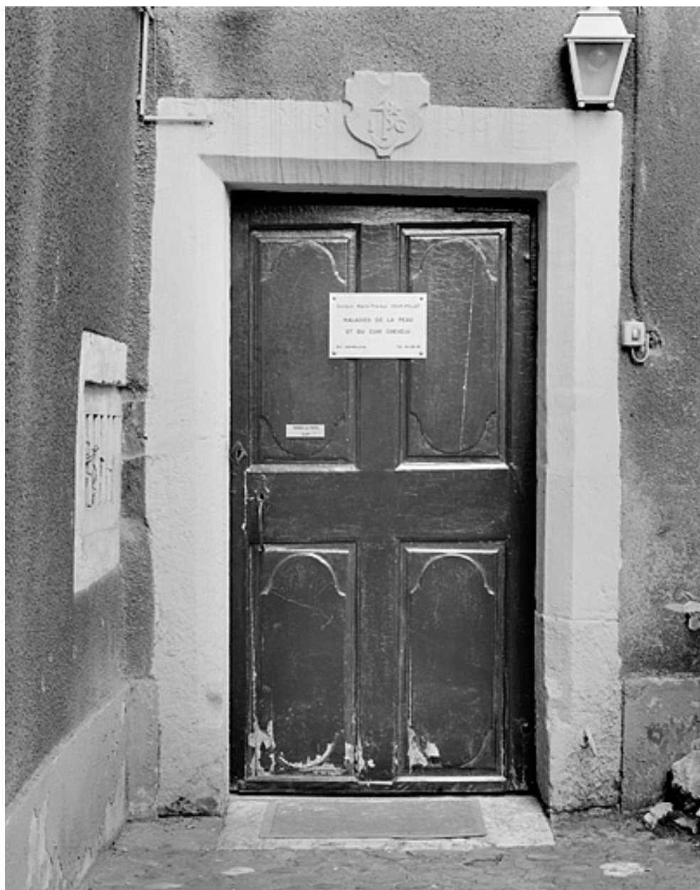
Porte de la tour d'escalier.
