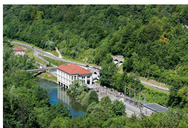
Centrale hydroélectrique au Moulin Artus, Liebvillers : vue d'ensemble plongeante, depuis le sud-est. Phot. Sonia Dourlot IVR43_20192501424NUC4A
