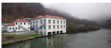
Centrale hydroélectrique : vue d'ensemble, depuis le sud-ouest (aval rive gauche). Phot. Yves Sancey IVR43_20122502014NUC2A
