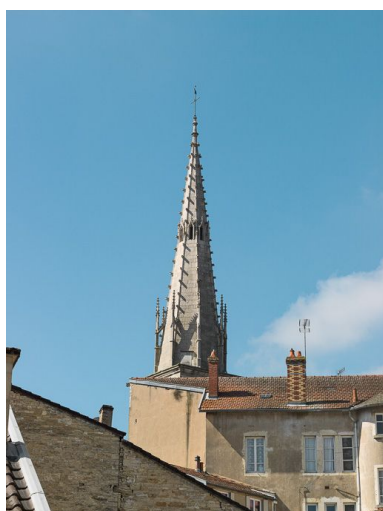
Détail du clocher. Phot. Pierre-Marie Barbe-Richaud IVR26_20172100026NUC2A
