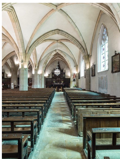
Vue d'ensemble du bas côté sud. Phot. Pierre-Marie Barbe-Richaud IVR26_20172100032NUC2A
