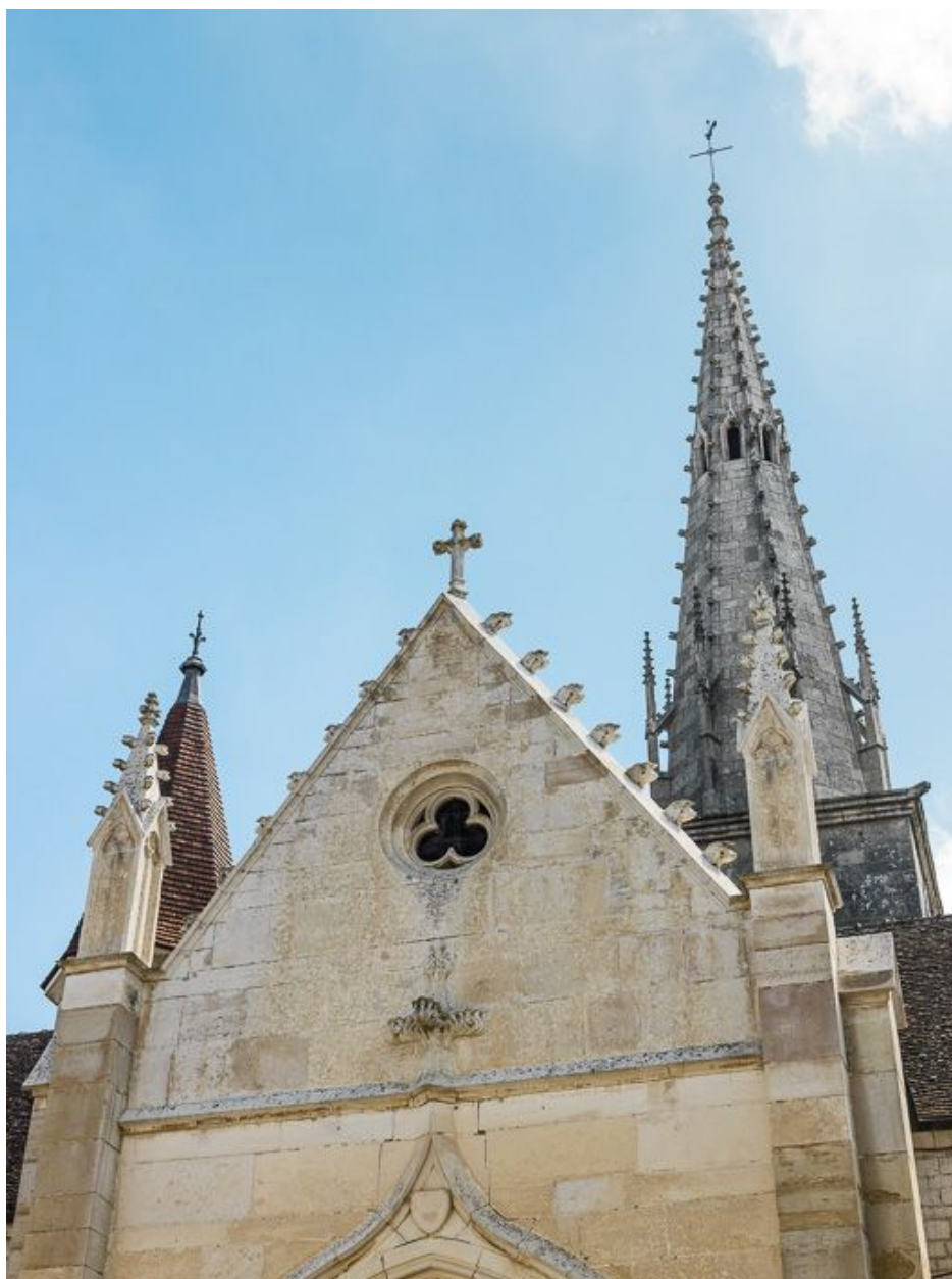
Façade ouest et flèche du clocher.
