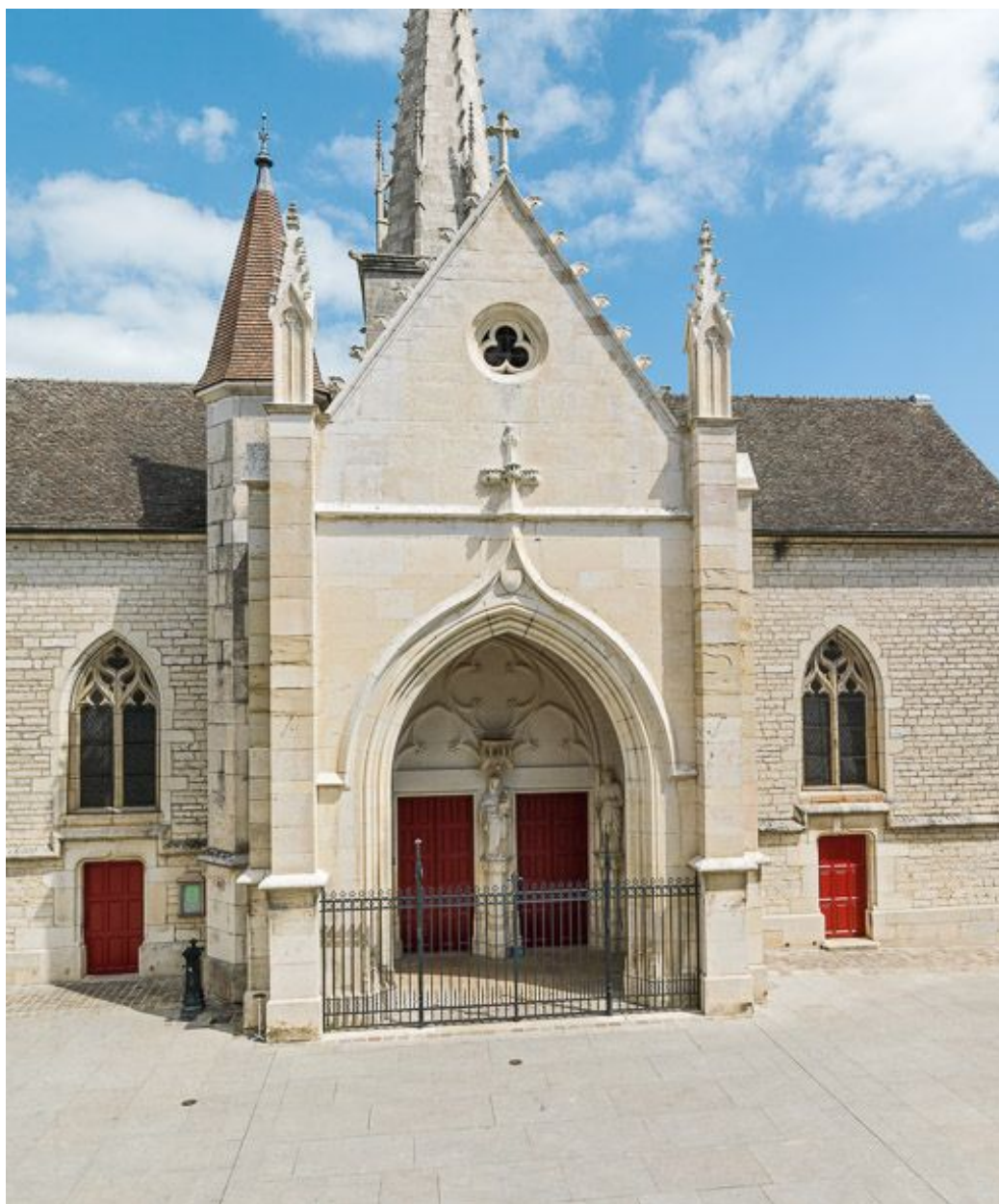
Vue d'ensemble de la façade ouest.
