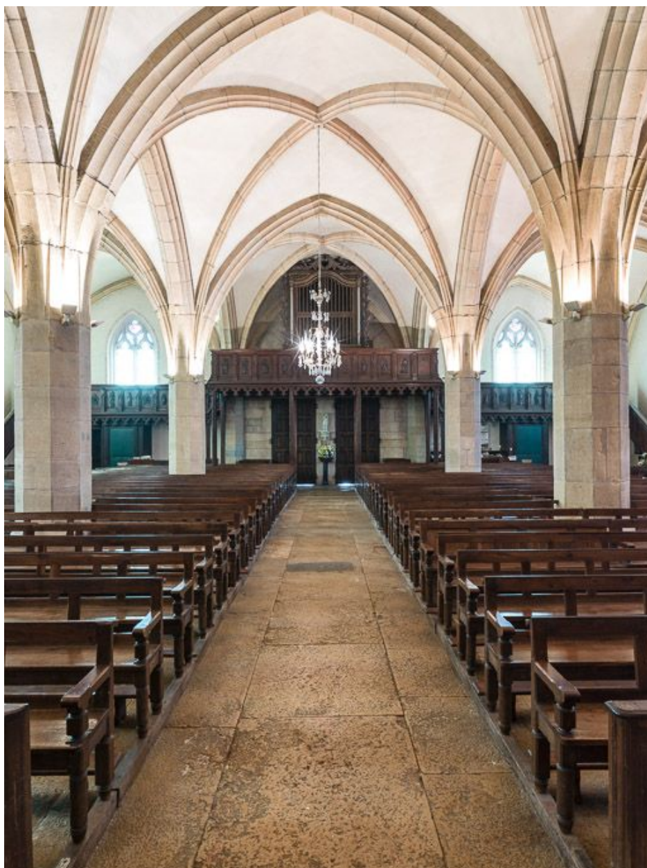
Vue d'ensemble depuis le chœur.
