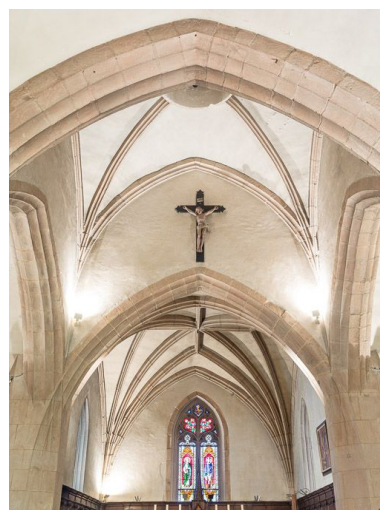
Voûtes du chœur et de la travée sous clocher. Phot. Pierre-Marie Barbe-Richaud IVR26_20172100034NUC2A
