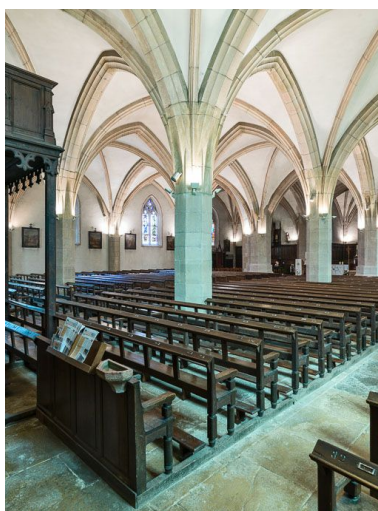
Vue d'ensemble depuis le bas côté droit. Phot. Pierre-Marie Barbe-Richaud IVR26_20172100030NUC2A
