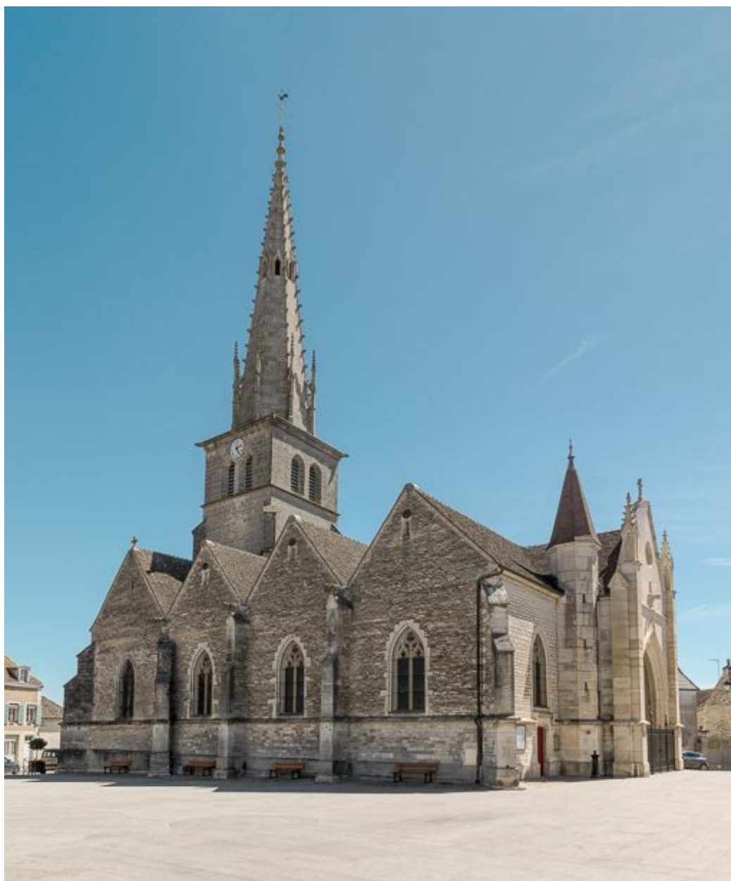
Vue d'ensemble de l'élévation nord.
