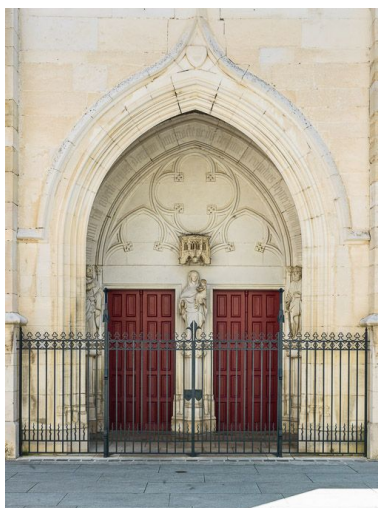
Le portail et les grilles. Phot. Pierre-Marie Barbe-Richaud IVR26_20172100024NUC2A
