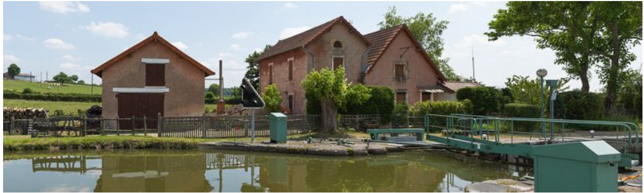
Vue d'ensemble du site atypique.
