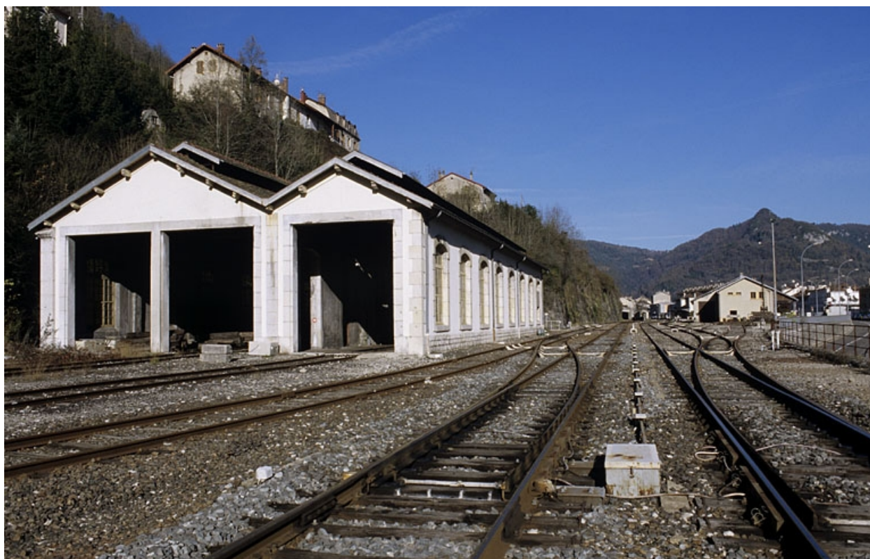
Remise ferroviaire : vue d'ensemble, depuis le sud.
