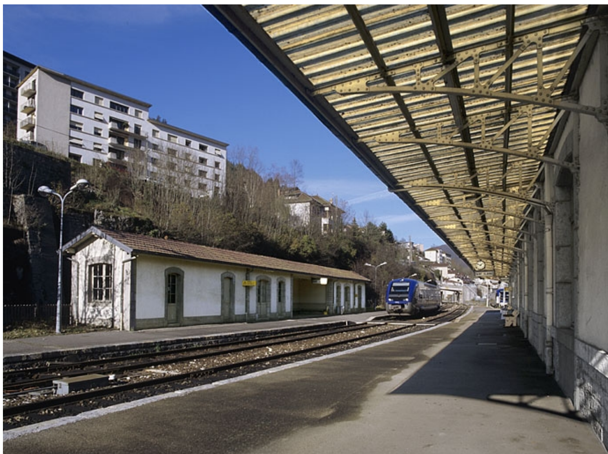
Abri-lampisterie : façade antérieure, de trois quarts gauche.
