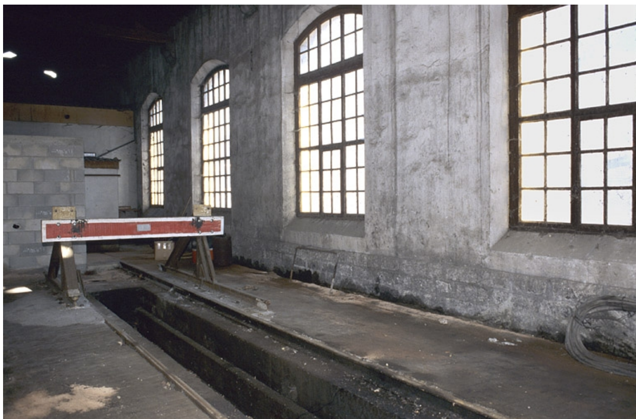
Remise ferroviaire : intérieur de la halle est.
