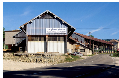
Les ateliers de fabrication depuis le sud-est. Au premier plan, l'ancienne parqueterie. Phot. Yves Sancey IVR43_19973901177ZA
