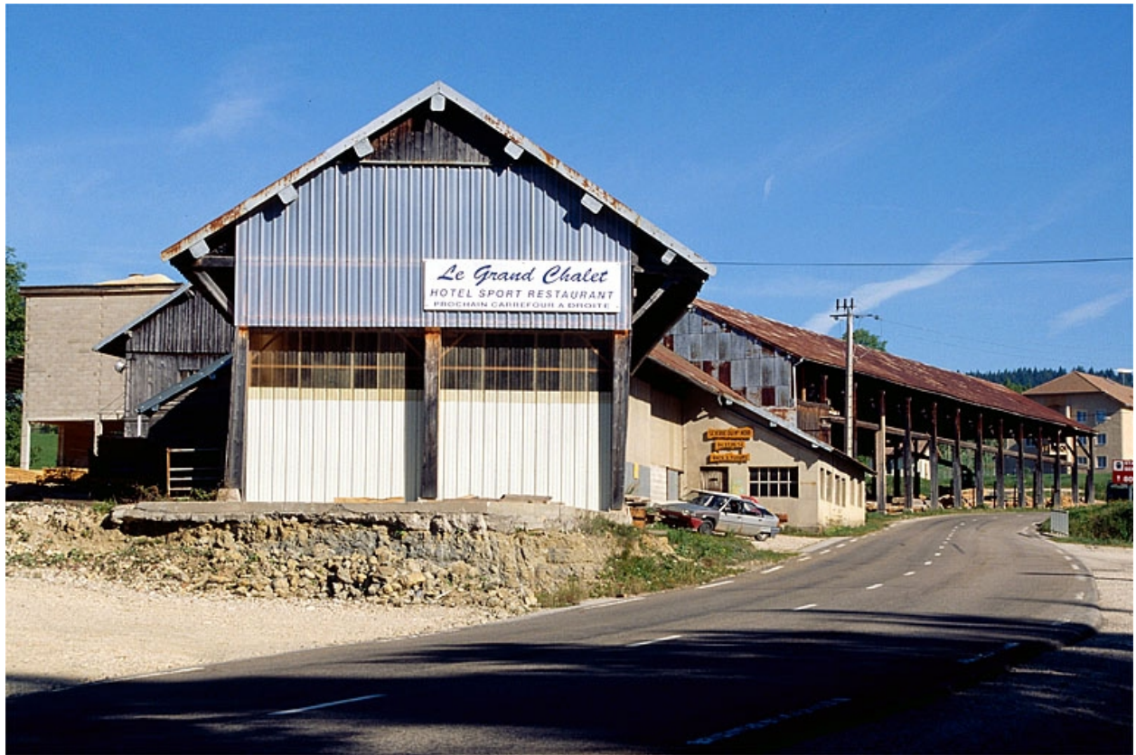
Les ateliers de fabrication depuis le sud-est. Au premier plan, l'ancienne parqueterie.
