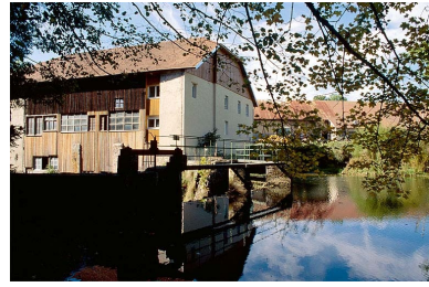
Le moulin Choudet vu de trois quarts arrière. Au premier plan, bassin de retenue. Phot. Yves Sancey IVR43_19973901171ZA
