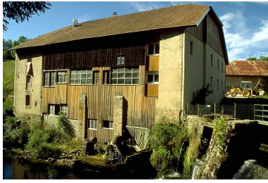
Façade postérieure du moulin Choudet. Phot. Yves Sancey IVR43_19973901173ZA
