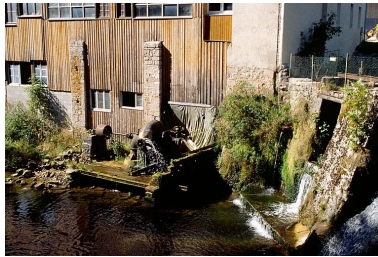
Moulin Choudet : la turbine et le barrage. Phot. Yves Sancey IVR43_19973901175ZA
