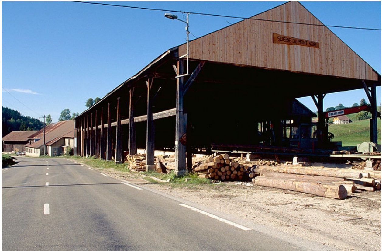
Façades est de la scierie.
