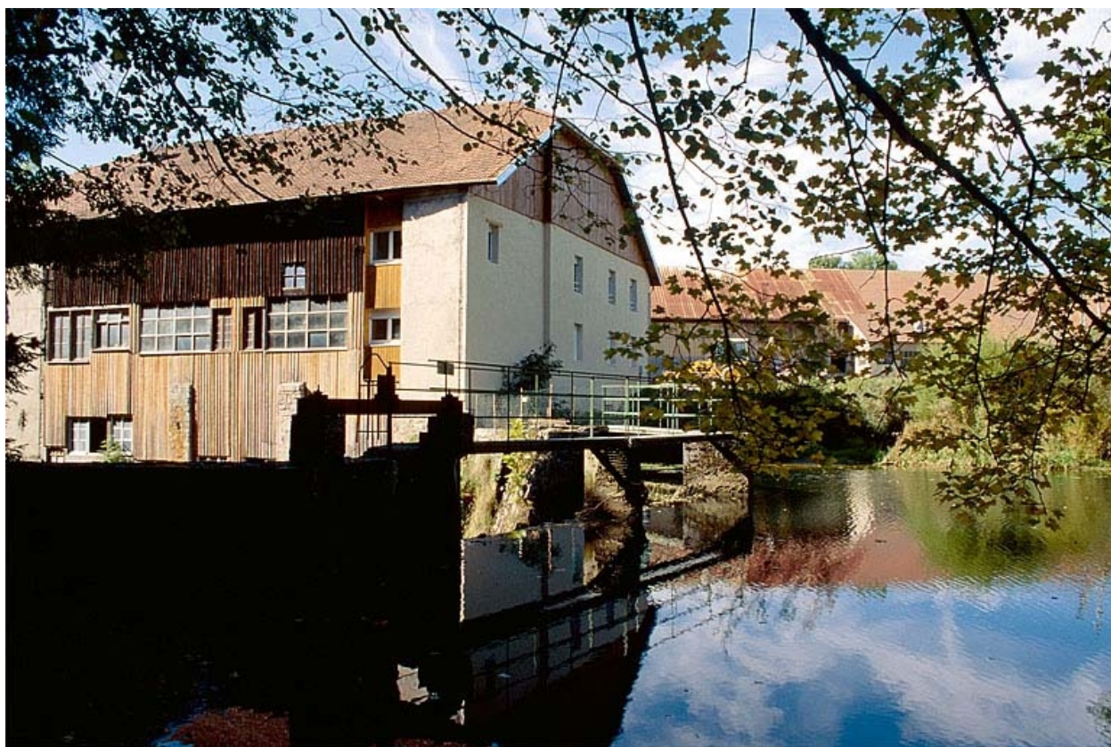
Le moulin Choudet vu de trois quarts arrière. Au premier plan, bassin de retenue.
