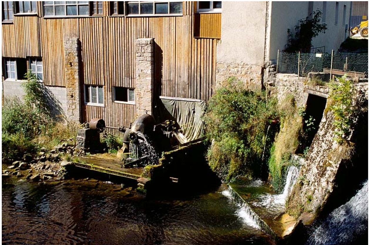
Moulin Choudet : la turbine et le barrage.
