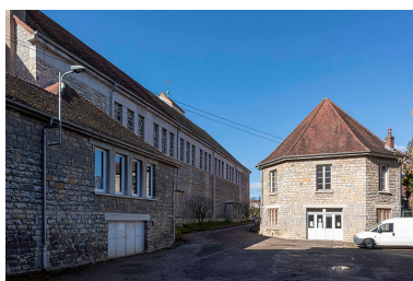
De gauche à droite : la façade ouest de l'église et du presbytère, la maison des œuvres - Cinéma Villarceau. Phot. Aline Thomas IVR43_20222500082NUC4A
