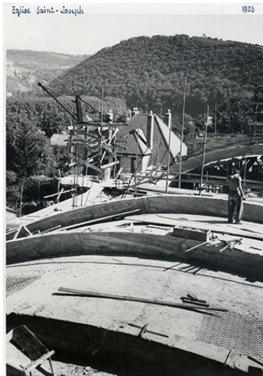
Chantier de l'église Saint-Joseph de Besançon : vue de la voûte en construction. 1953. Autr. René Tournier IVR43_20212500153NUC4A
