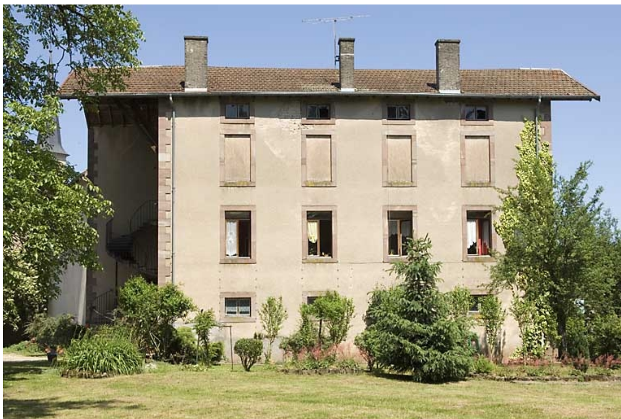
Atelier de distillation et chai (?). Façade sud-ouest.
