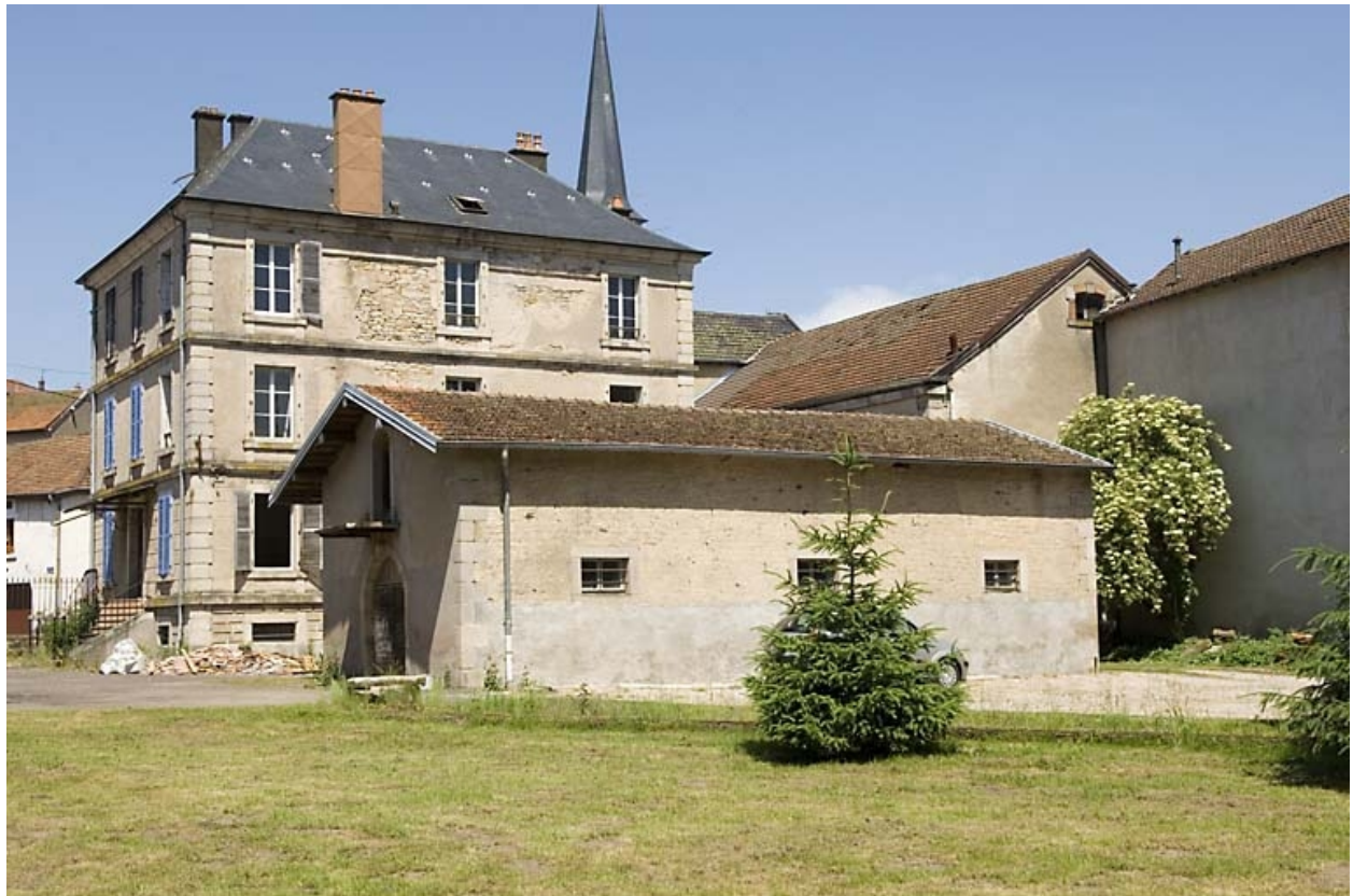
Logement patronal et chai (?) depuis l'ouest.
