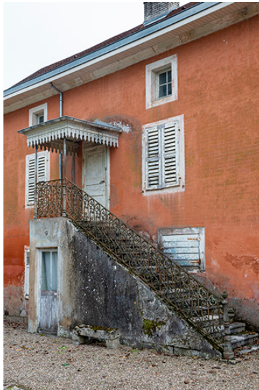
Façade nord, perron. Phot. Jérôme Mongreville IVR43_20187000806NUC4A
