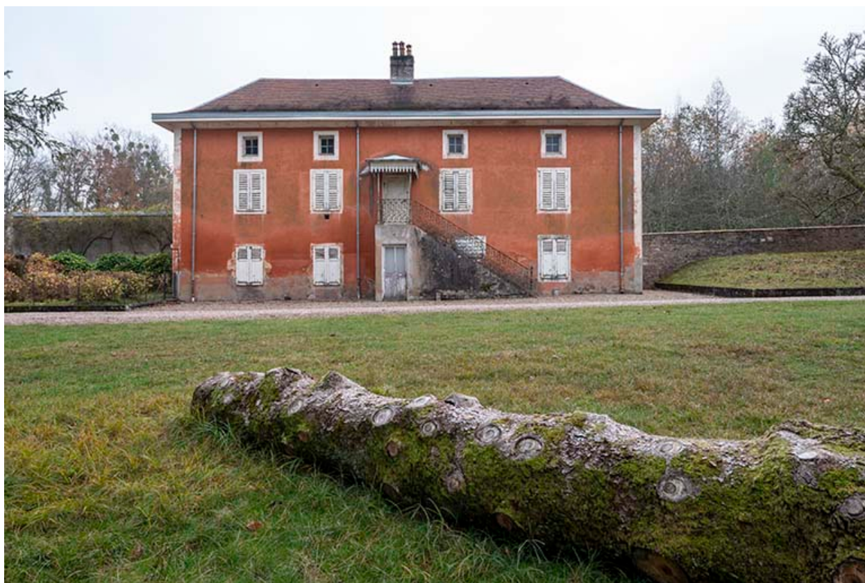
Façade nord, vue d'ensemble.
