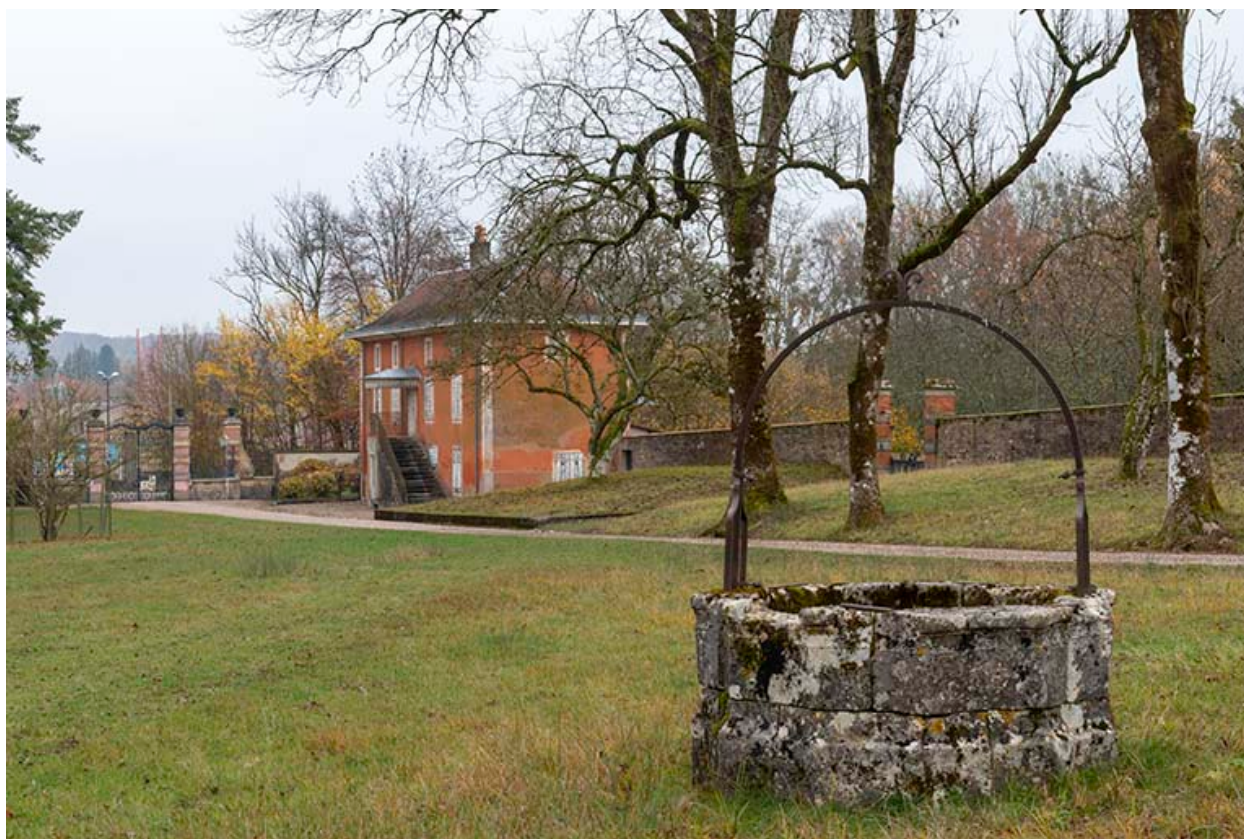
Vue d'ensemble depuis l'ouest.
