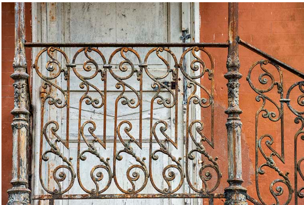
Garde-corps du perron.
