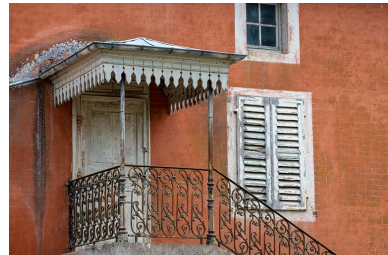
Façade nord, perron. Phot. Jérôme Mongreville IVR43_20187000807NUC4A
