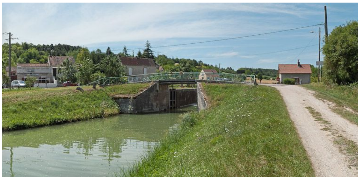
Vue du pont depuis l'aval.
