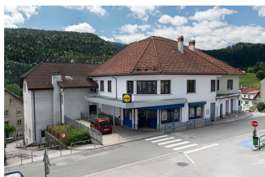
Vue d'ensemble, depuis le nord. Phot. Sonia Dourlot IVR43_20162501384NUC4A
