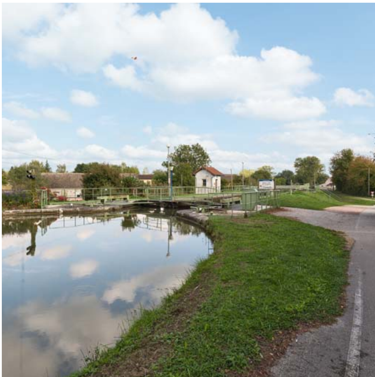
Vue d'ensemble du site d'écluse.
