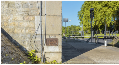
Repère de crue. Phot. Thierry Kuntz IVR26_20162101383NUC4A
