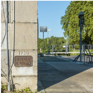
Repère de crue. Phot. Thierry Kuntz IVR26_20162101384NUC4A
