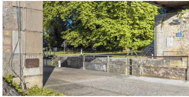
Repère de crue. Phot. Thierry Kuntz IVR26_20162101381NUC4A
